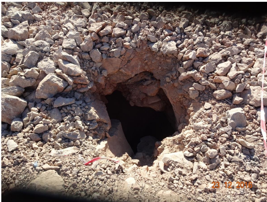
Εικόνα 15:Το έκοιλο που αποκαλύφθηκε στη θέση ανέγερσης του γειτονικού κτιρίου
