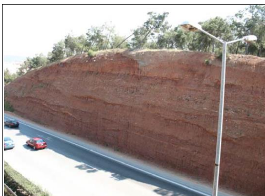
Σχήμα 2.5 Τεχνητό πρανές στην περιοχή της περιφερειακής οδού Θεσσαλονίκης, όπου φαίνεται η διαστρωμάτωση της σειράς των Ερυθρών Αργίλων και οι εναλλαγές αργίλων και φακοειδών οριζόντων με χάλυκες και λατύπες (Ζερβοπούλου, 2010).
