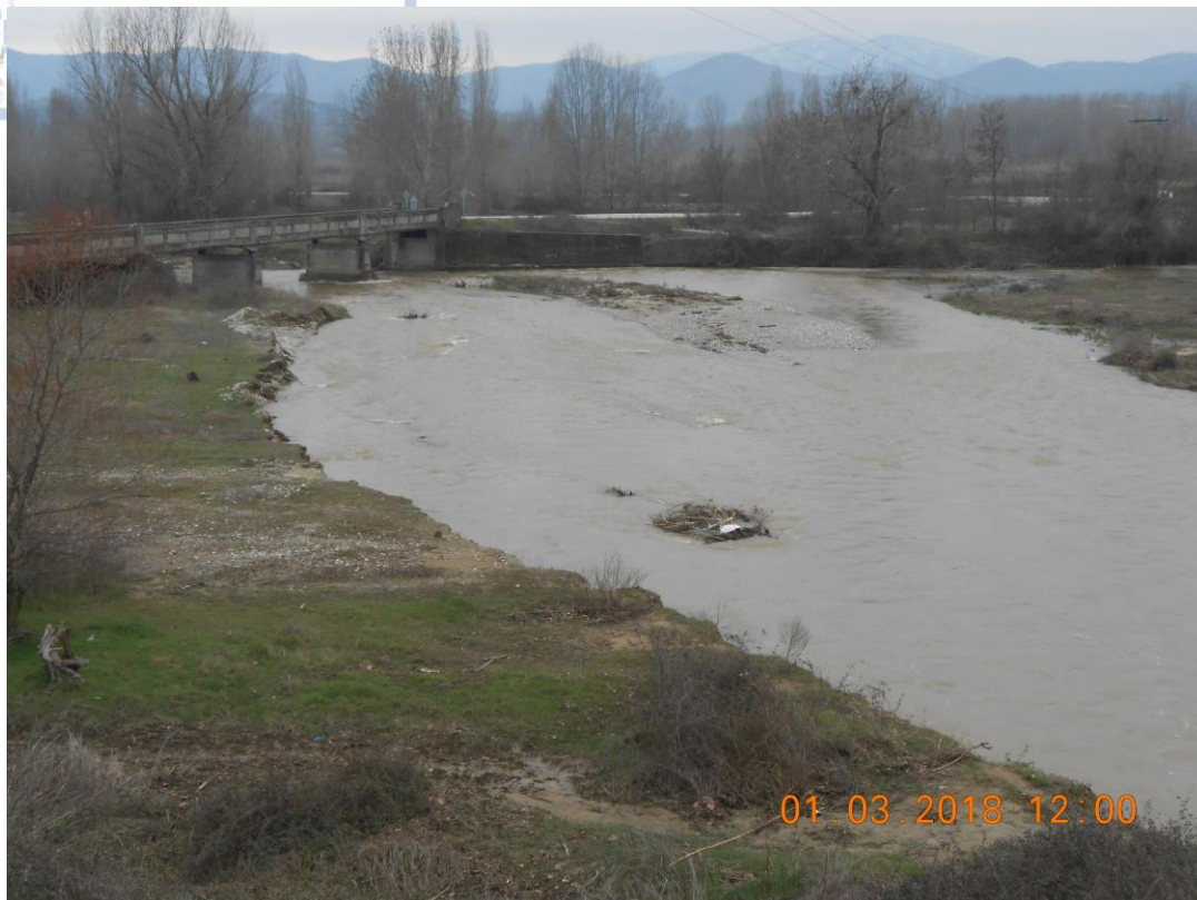
Φωτ. 7: Άποψη ποταμού Τιταρήσιου (Γέφυρα Βλαχογιαννίου).
