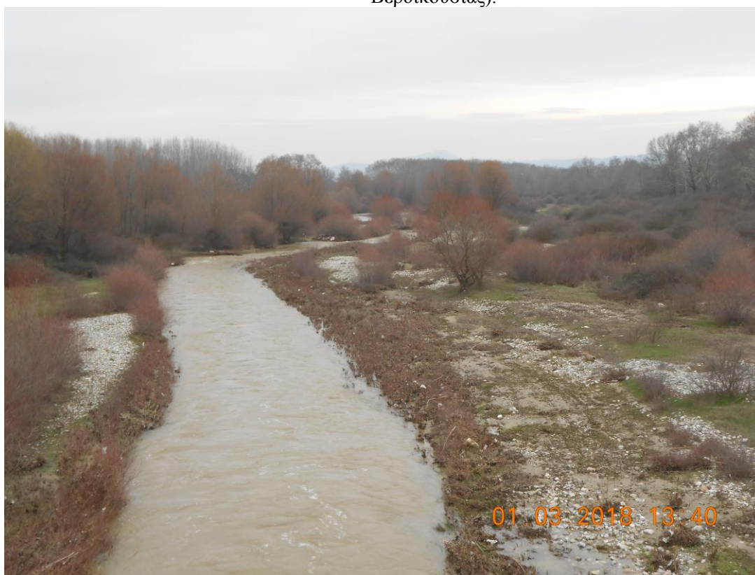
Φωτ. 12: Άποψη ποταμού Βούλγαρη (Περιοχή κατάντη της γέφυρας της Ε.Ο. Ελασσόνας - Βερδικούσιας).
