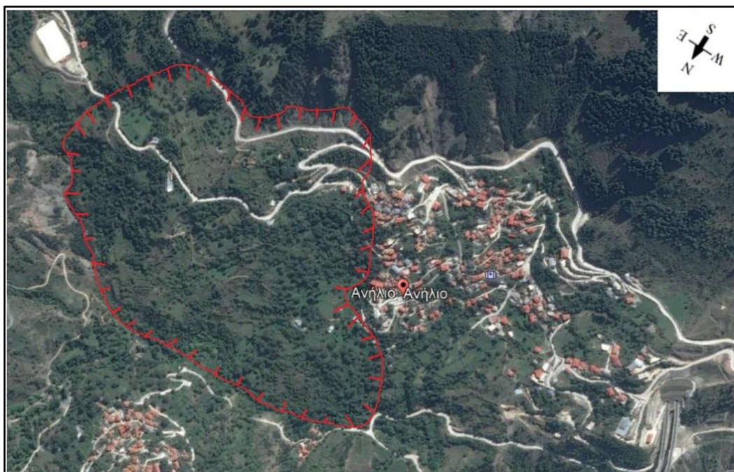
Εικόνα 5. 21 Κατολίσθηση στην ανατολική είσοδο του Ανηλίου, με κόκκινο σημειώνονται τα όρια της κατολίσθησης (εικόνα από Google Maps Pro).
