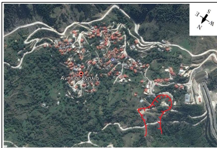
Εικόνα 5. 31 Κατολίσθηση δυτικής εισόδου, με κόκκινο σημειώνονται τα όρια της κατολίσθησης, (Google Maps Pro Τροποποιημένο).
