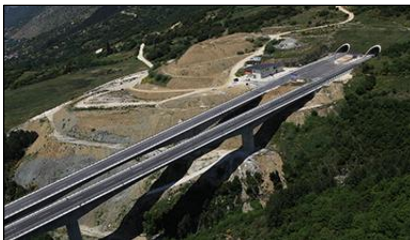
Εικόνα 5. 3 Δίδυμη σήραγγα Εγνατίας Οδού στο Ανήλιο (εικόνα από την επίσημη σελίδα της Εγνατίας Οδού Α.Ε)
