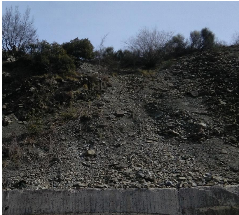
Εικόνα 6. 2 Υλικά κατολίσθησης, άργιλος με χαλίκια και πέτρες
