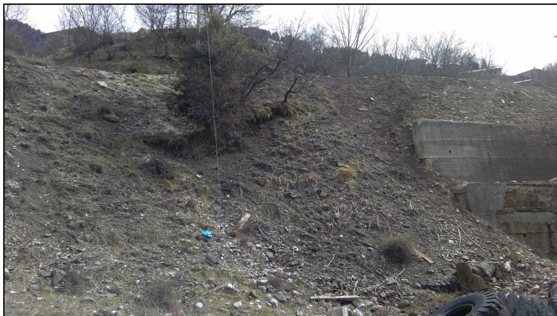
Εικόνα 5. 33 Περιοχή στο μέσο της κατολίσθησης, παρατηρούνται τα υλικά της κατολίσθησης (φωτογραφία από τον συγγραφέα).
