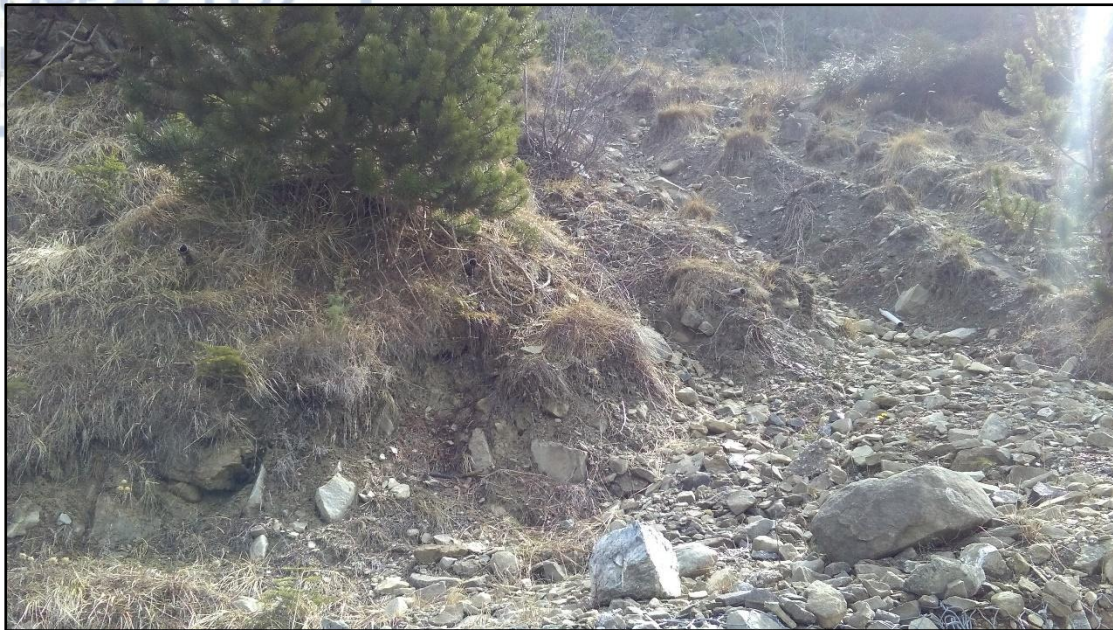
Εικόνα 5. 28 Εξάρσεις του αναγλύφου, σημάδι ύπαρξης κατολίσθησης (φωτογραφία από τον συγγραφέα).
