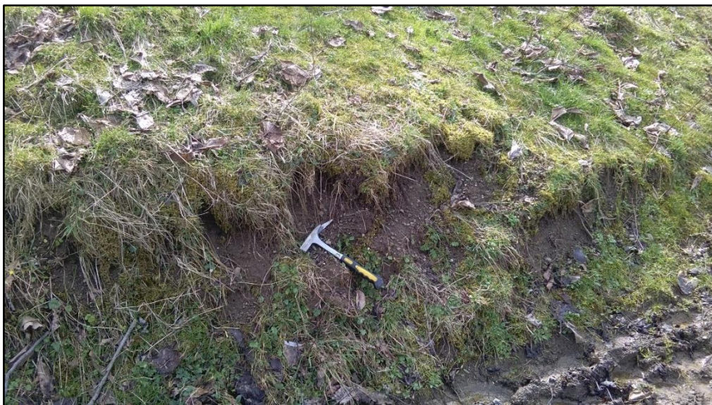
Εικόνα 5. 40 Εξάρσεις του αναγλύφου, σημάδι ύπαρξης κατολίσθησης (φωτογραφία από τον συγγραφέα).
