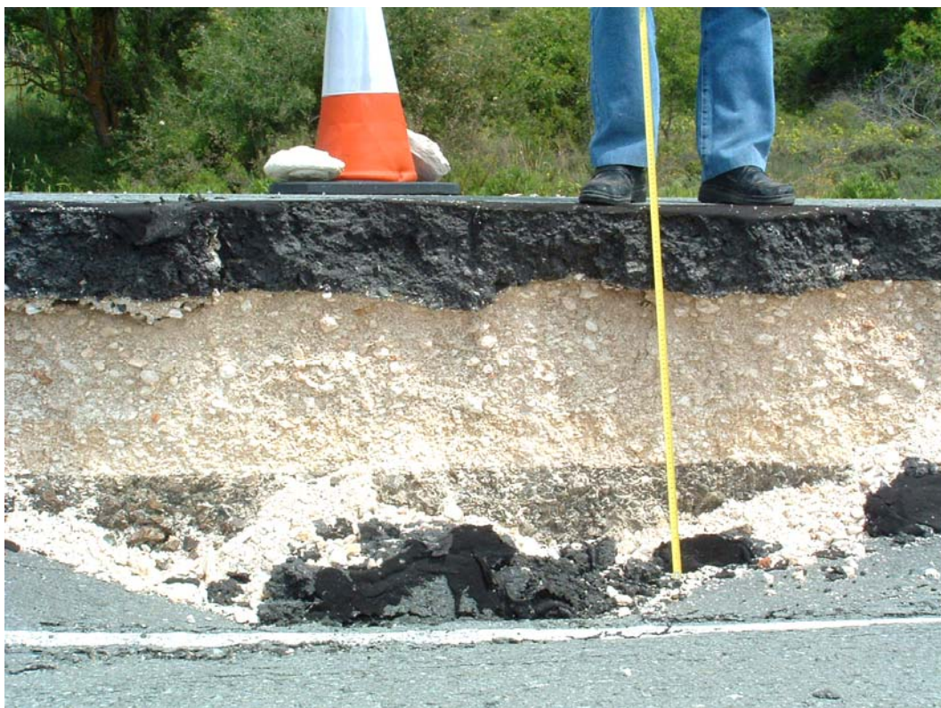
Φωτογραφία 4. Μέτρηση της μεγαλύτερης μετατόπισης του βασικού επιπέδου του δρόμου υπολογίστηκε για το συγκεκριμένο γεγονός σε 80 εκ..
