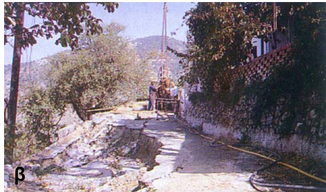
Εικόνες 16α – 16β. Κατολισθήσεις που επηρεάζουν υφιστάμενους δρόμους και παρακείμενα σπίτια.
