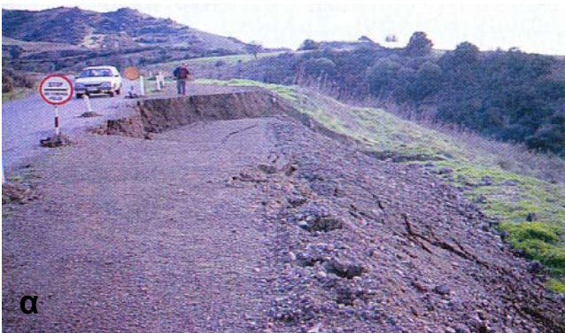
Εικόνες 16α – 16β. Κατολισθήσεις που επηρεάζουν υφιστάμενους δρόμους και παρακείμενα σπίτια.
