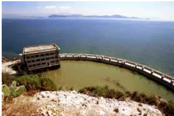
Άποψη φράγματος και αντλιοστασίου Αναβάλου.
