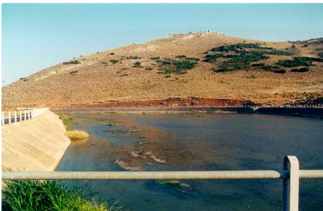
Αγωγοί μεταφοράς του νερού στο Σκαφιδάκι.
