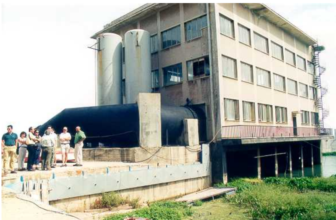
Το αντλιοστάσιο του φράγματος.
