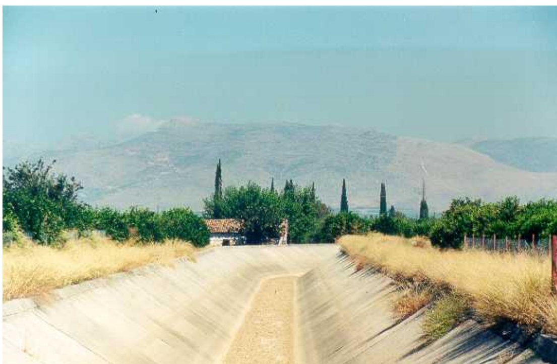
Αγωγός μεταφοράς νερού στο Κιβέρι..
