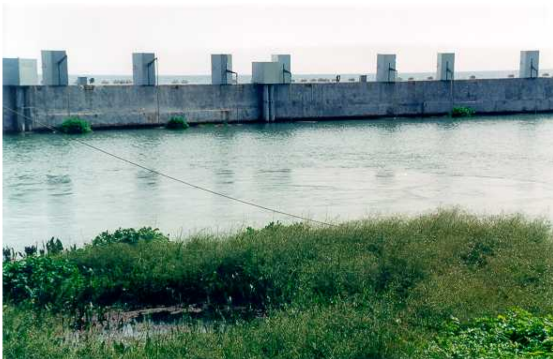
Τμήμα του τοιχίου του φράγματος από την εσωτερική πλευρά.
