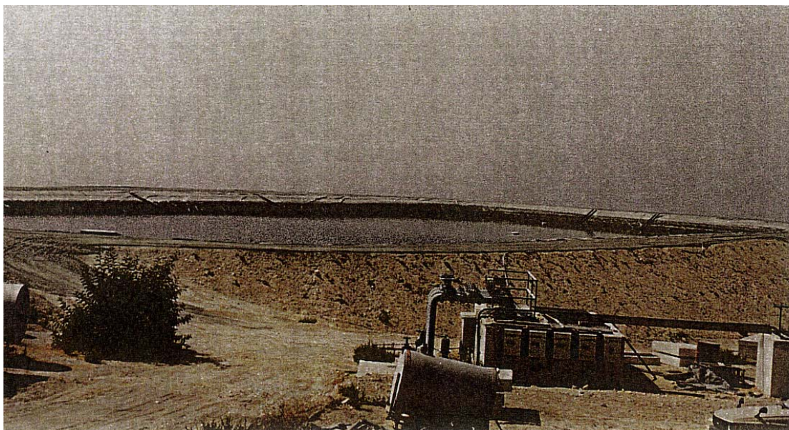
ΦΩΤΟΓΡ. 1 - Δεξαμενή Αποθήκευσης Μονής
