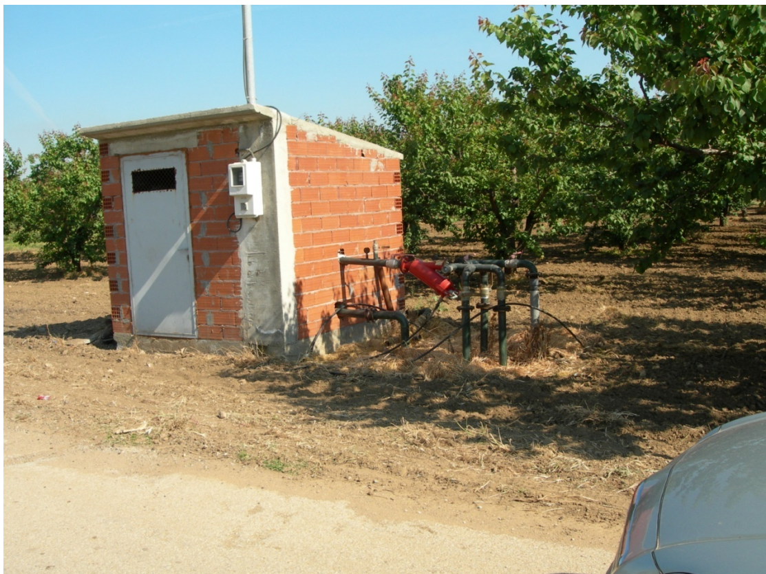
Φωτογραφία 2: γεώτρηση Νο14
