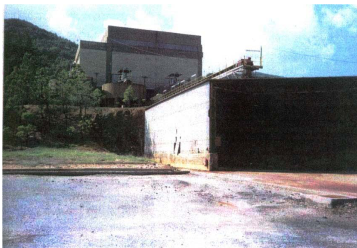
Το Εργοστάσιο εμπλουτισμού του μεταλλείου Ολυμπιάδας και χώρος αποθήκευσης του
