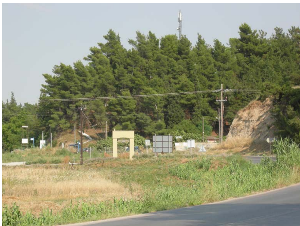
Φωτ 4. Το μέτωπο του ρήγματος του Ανθεμούντα και η κατά βάθος διάβρωση των χειμάρρων του υδρογραφικού δικτύου.
