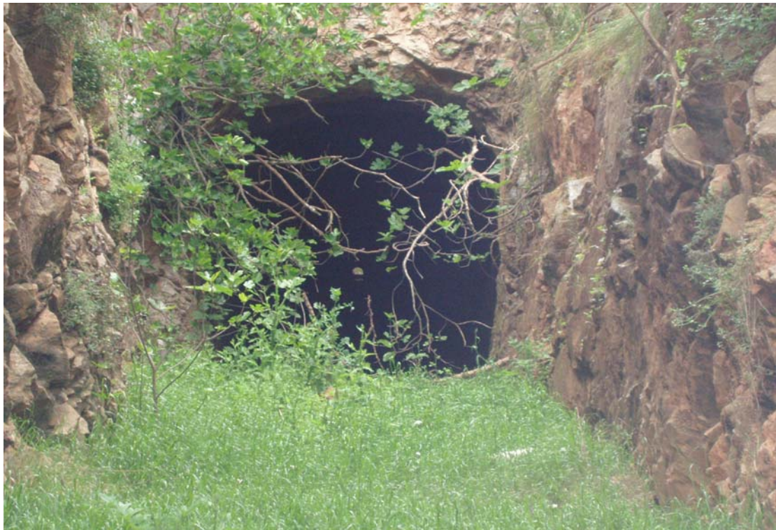
Φωτογραφία 4. Υπόγεια σήραγγα αποστράγγισης στο Βορειοανατολικό τμήμα της Παραλίμνης που οδηγεί στο Βόρειο Ευβοϊκό κόλπο. Στο βάθος διακρίνεται η άλλη άκρη του τούνελ.
