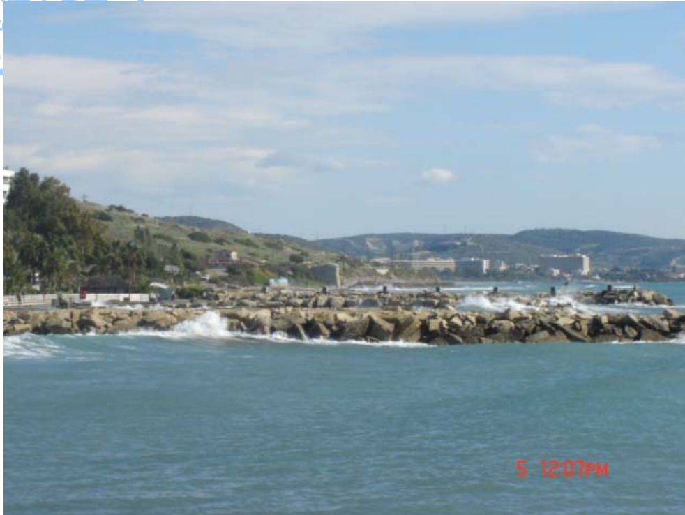
Σχήμα 9: Κάθετοι πρόβολοι (groynes) στην υπό μελέτη περιοχή
