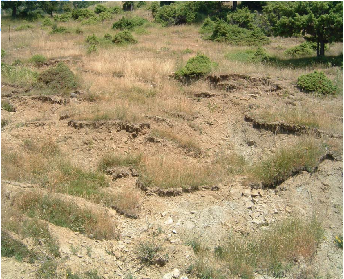
Φωτο 7: Ερπυσμοί στα πρανή της Κατολίσθησης Α - Γήπεδο.
