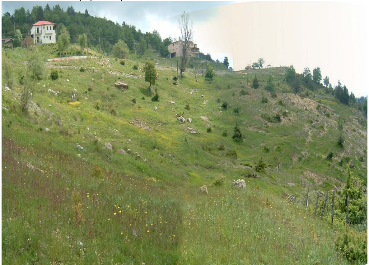
Φωτο 6: Κατολίσθηση Β – Κύρια κατολίσθηση.
