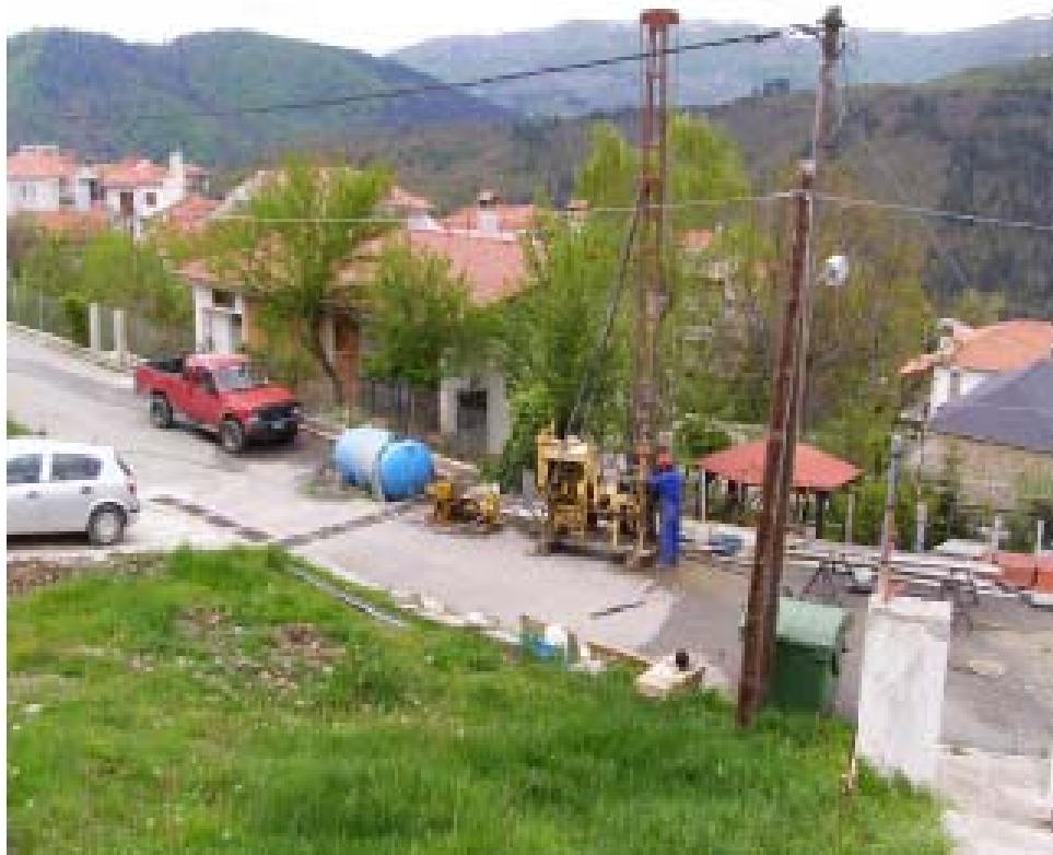
Θέση Ερευνητικής Γεώτρησης Γ1
