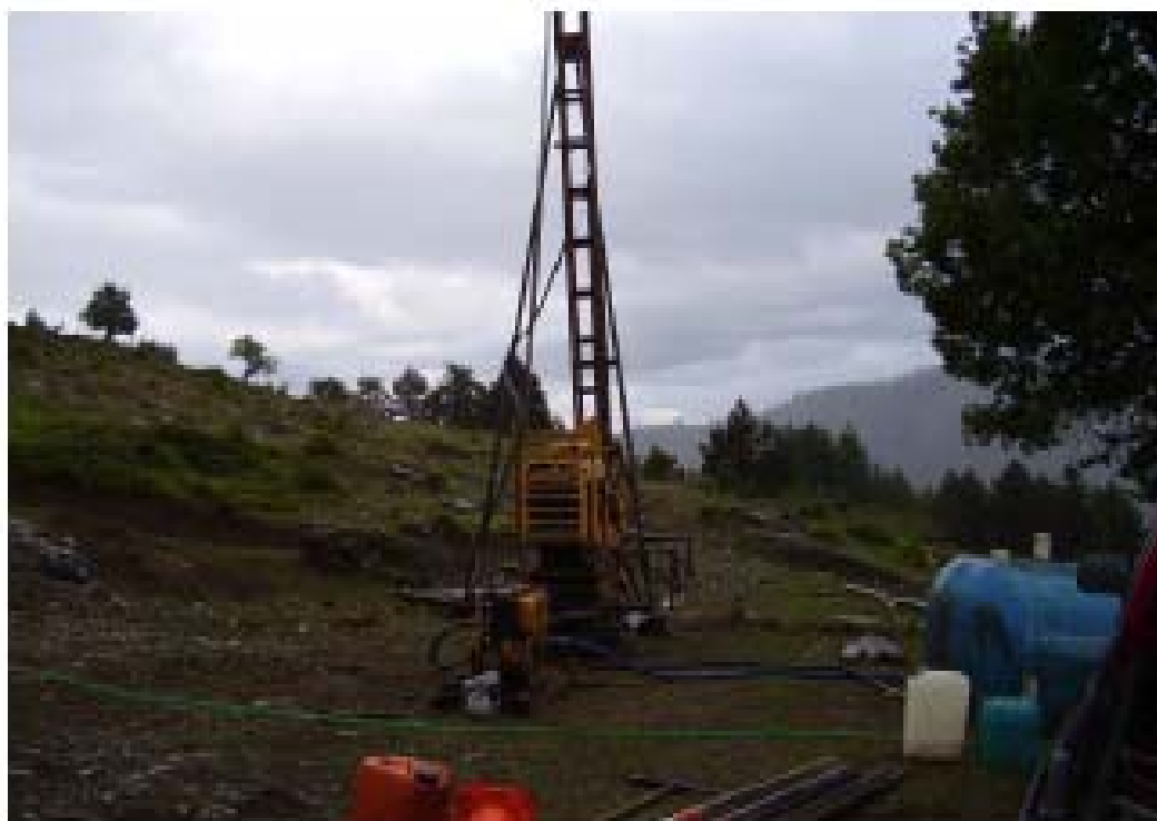
Θέση Ερευνητικής Γεώτρησης Γ9
