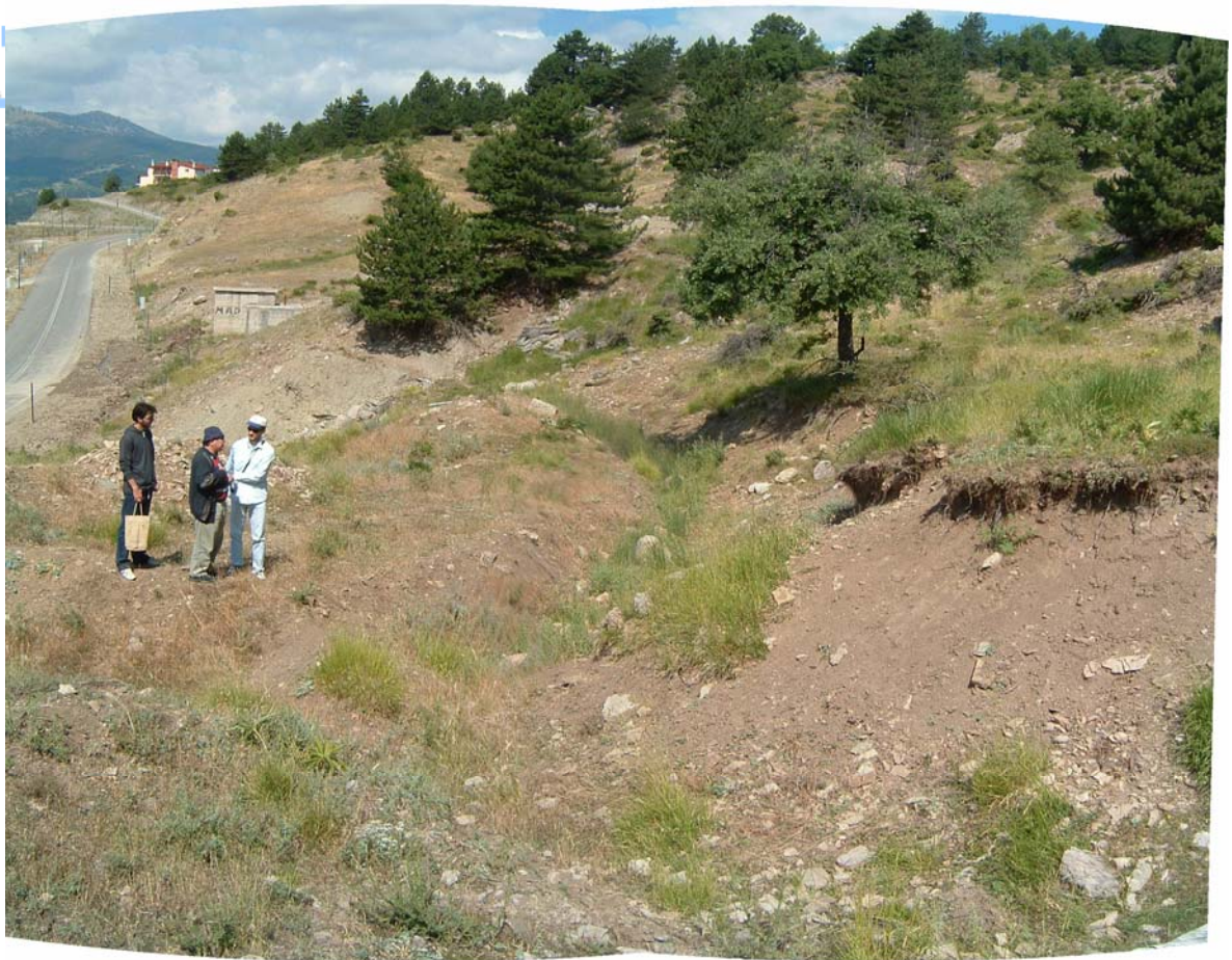
Φωτο 5: Κατολίσθηση Α – Γήπεδο.
