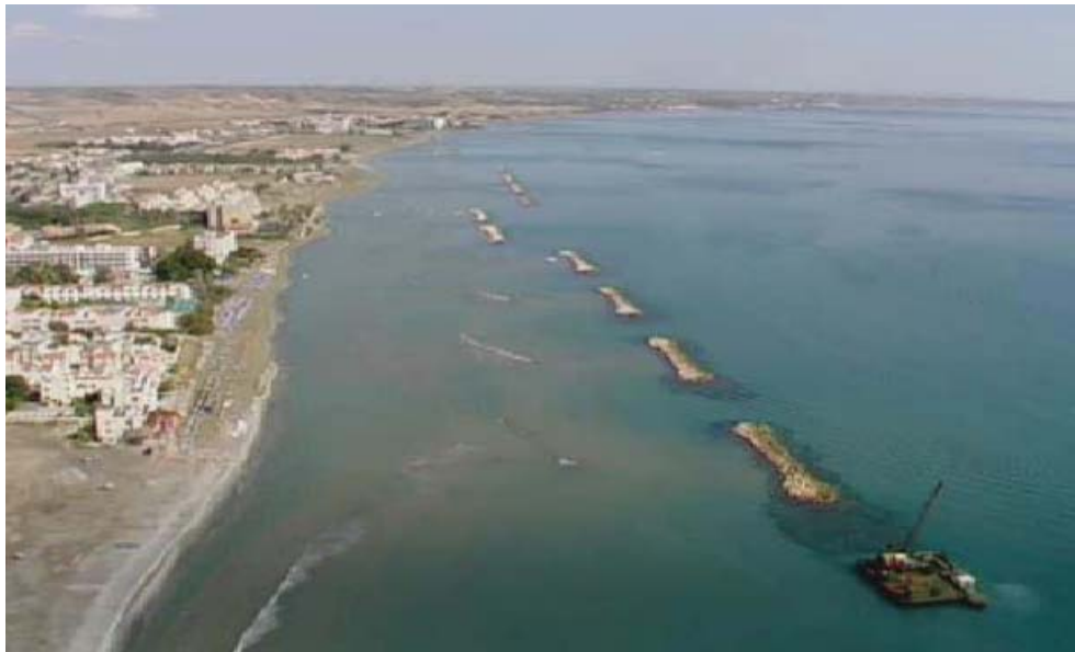
(Κατασκευή παρ/λων κυματοθραύστων στην Λάρνακα) – Πηγή:(Σταυρινή Θεοδοσίου - NATIONAL POLICY FRAMEWORK FOR COASTAL EROSION)
