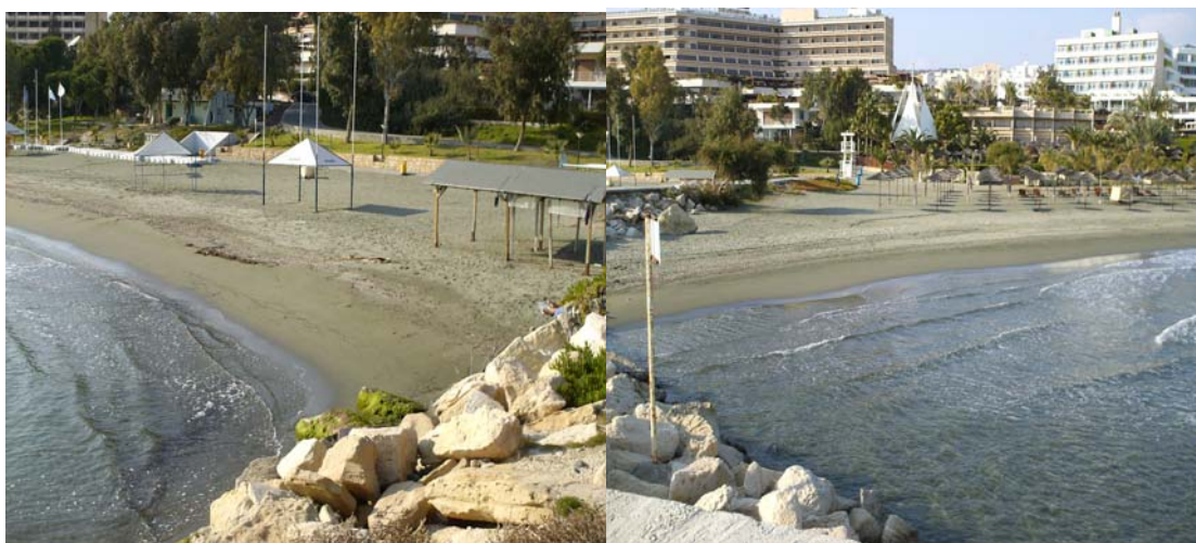
(Αριστερά από τον κυματοθραύστη η παραλία διαβρώνεται ενώ δεξιά υπάρχει σημαντική απόθεση άμμου και η παραλία έχει σχεδόν διπλάσιο μήκος-Παραλία Four Seasons Λεμεσός.) Πηγή:Δ.Στιβαρίδης
