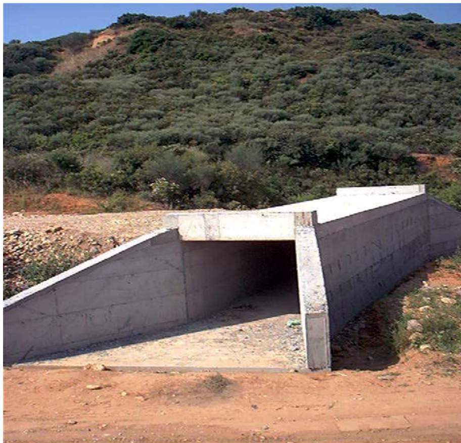
Φωτογραφία 15: Τσιμεντένιο έργο διευθέτησης σε πλευρικό χείμαρρο του Ολύνθιου. ( λίγα χμ βόρεια της Νέας Ολύνθου)
