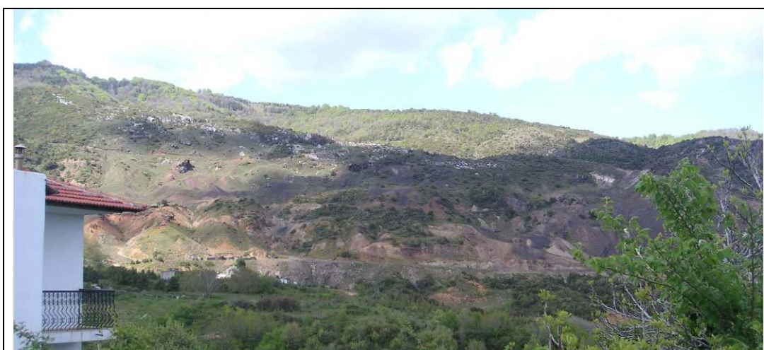
Σχήμα 11. Τεταρτογενείς αποθέσεις συνεκτικών πλευρικών κορημάτων ερυθρού χρώματος με γωνιώδη τεμάχια από τα πετρώματα του υποβάθρου.
