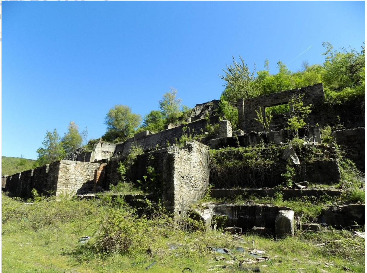
Σχήμα 4.1. Εγκαταλελειμμένες εγκαταστάσεις της μονάδας εμπλουτισμού μεταλλεύματος (Φωτογραφία Β. Μέλφος)
