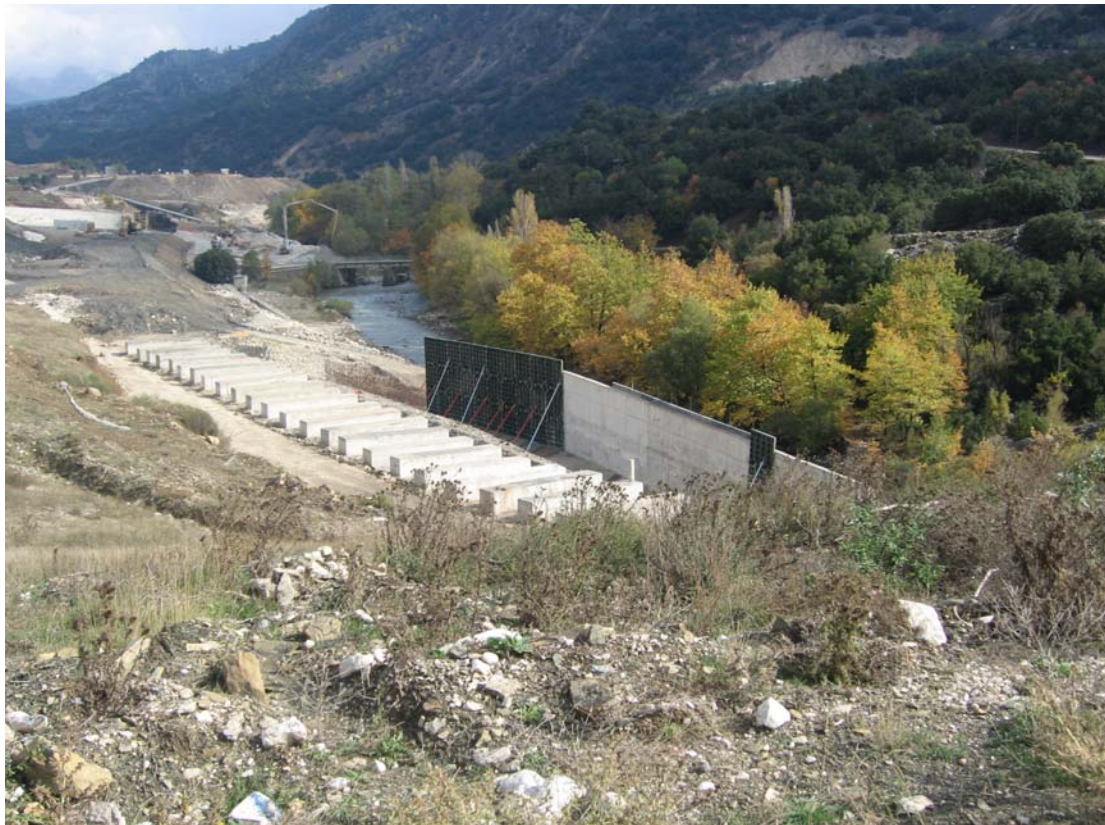
Φωτογραφία 11: Τοίχος αντιστήριξης και μπαρέτες
