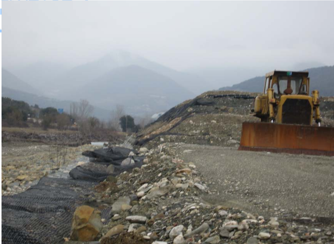
Φωτογραφία 10: Οπλισμένο επίχωμα στην υποπεριοχή B2
