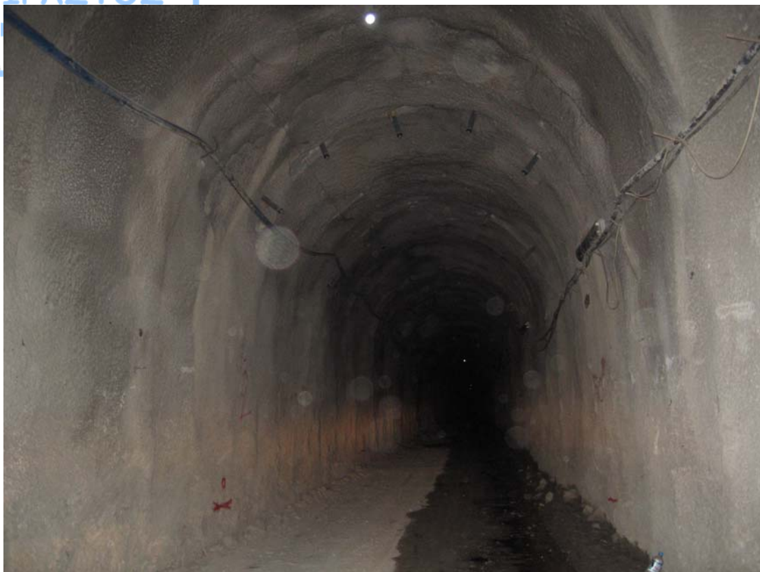
Φωτογραφία 13: Αποστραγγιστική σήραγγα στο ανάντη τμήμα της κατολίσθησης
