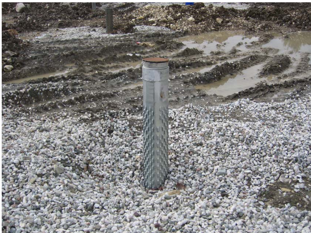
Φωτογραφία 12: Αποστραγγιστικό φρεάτιο που στραγγίζει στην ποτάμια αναβαθμίδα
