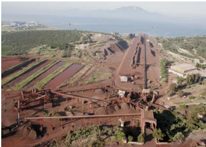
Εικόνα 11. Εγκαταστάσεις εμπλουτισμού (Αποστολίκας 2007)
