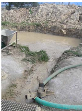
Εικόνα 30 : Αυλάκι για την κυκλοφορία του πολτού
