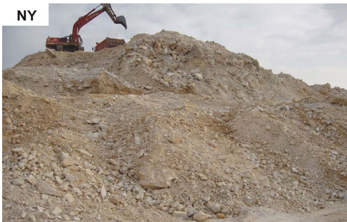
Φωτ. 7.2.1. Τομή του υπό κατασκευή τμήματος Νυμφόπετρας-Ρεντίνας της Εγνατίας Οδού από όπου συλλέχθηκε το δείγμα NY.
