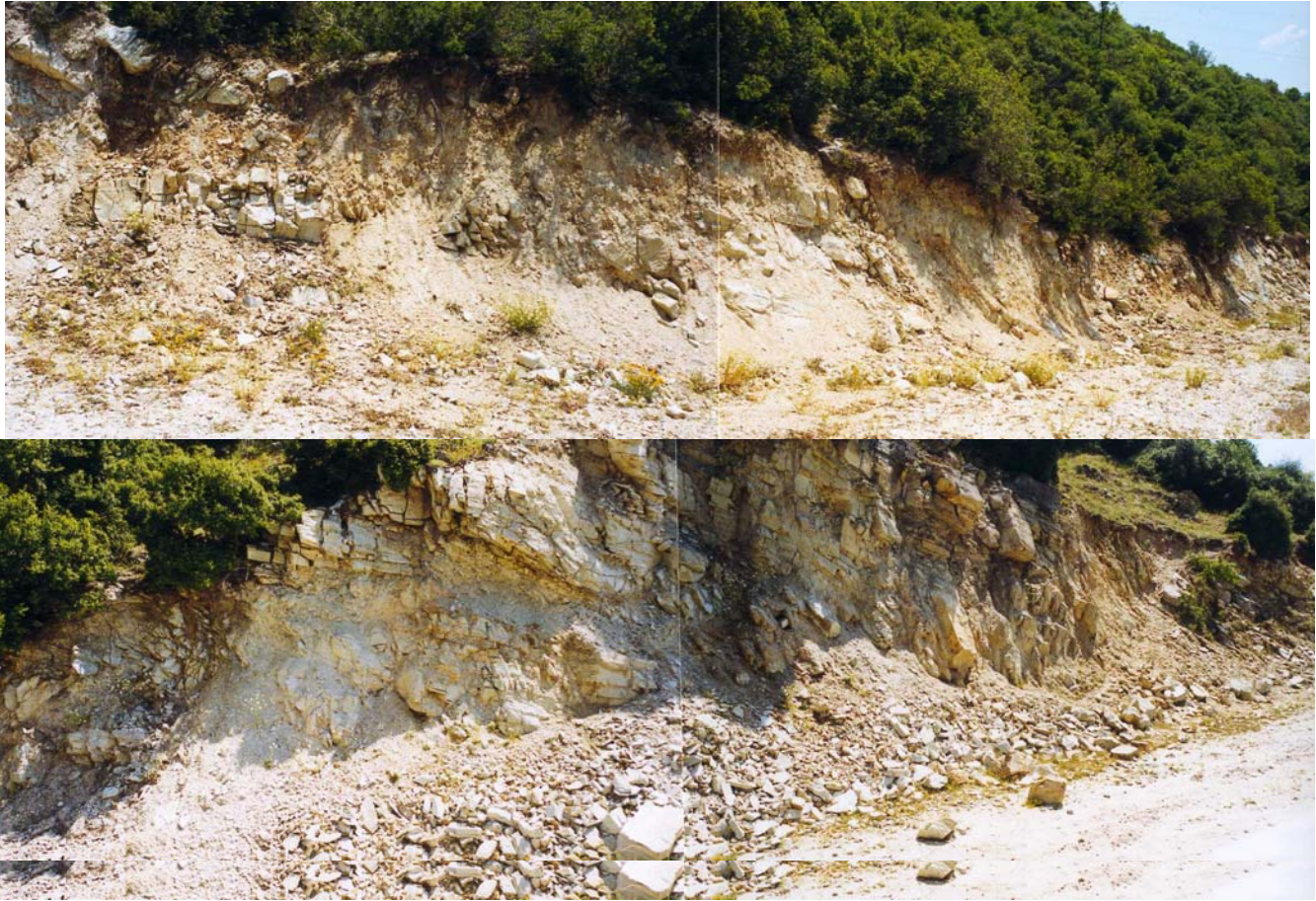
Φωτ. 2: Ζώνη ρήγματος και έντονα αποδιοργανωμένοι γενεύσιοι ανάντη της εισόδου της Σ13.
