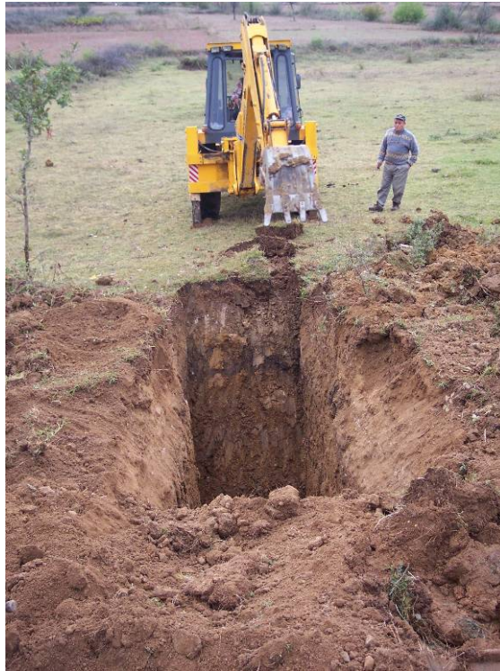
Εικόνα 4.6.3.2. Εκσκαφή υπό την καθοδήγηση του καθηγητή Tutkun.
