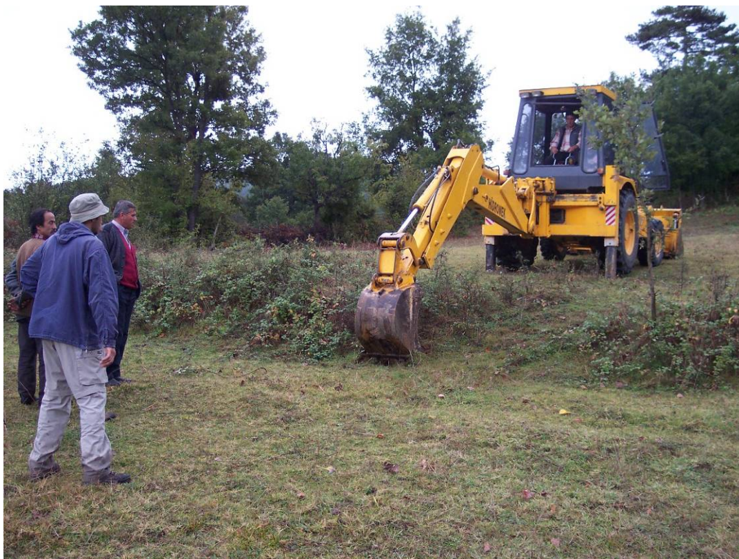
Εικόνα 4.6.3.1. Πρανές του ρήγματος που προκάλεσε το σεισμό του 1953.
