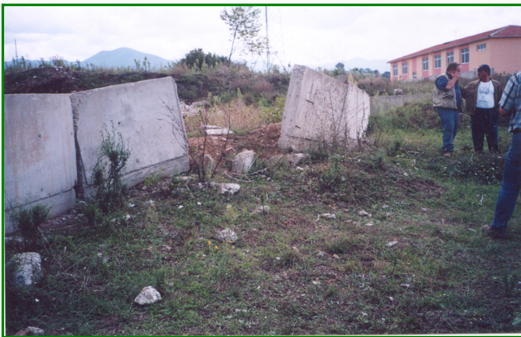
Εικόνα 4.5.3.1. Στη θέση κατασκευής της τομής ΚΥ-1 η διάρρηξη είχε οριζόντια δεξιόστροφη μετατόπιση της τάξης των 3 περίπου m, όπως φαίνεται και από τη μετατόπιση του τοιχίου. Όψη προς Ν.
