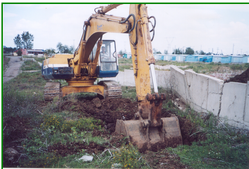
Εικόνα 4.5.3.2. Φάση κατασκευής της τομής ΚΥ-1. Όψη προς Β. Στη θέση της διάρρηξης και ανατολικά του τοιχίου, υπήρχαν πολυώροφες οικοδομές οι οποίες κατέρρευσαν κατά τη διάρκεια του σεισμού.
