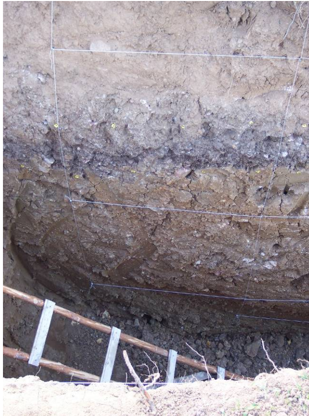
Εικόνα 4.6.2.14. Λεπτομέρεια του τοιχώματος της τομής. Εντοπίζονται διαφορές στην πυκνότητα ανά σημεία, ύπαρξη φακών και κροκαλών σε άτακτη διάταξη.
