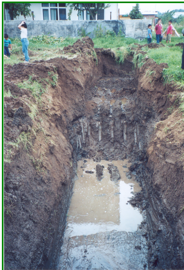
Εικόνα 4.5.2.6. Γενική άποψη του κύριου κλάδου της τομής ΑΥ-2, όπου διακρίνονται οι ιλυώδεις αποθέσεις και ο υψηλός υδροφόρος ορίζοντας. Όψη προς Β.
