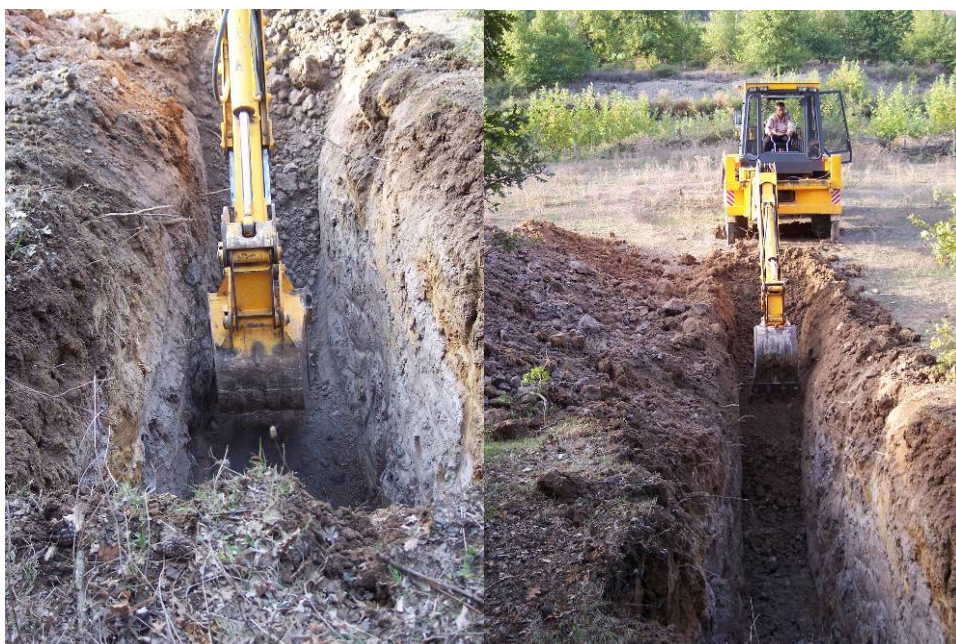
Εικόνα 4.6.2.6. Διαδικασίες εκσκαφής στο Karaköy στις 11/10/2004.
