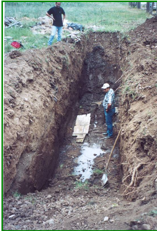
Εικόνα 4.5.2.1. Γενική άποψη προς Β της τομής ΑΥ-1, στο σημείο όπου διερχόταν η σεισμική διάρρηξη του 1999. Διακρίνεται ο υψηλός υδροφόρος ορίζοντας.
