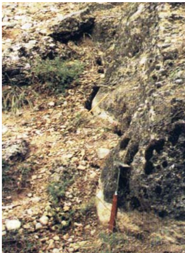
Σχ 6.2.5 Επιφανειακή διάρρηξη στη βόρεια πλευρά του λόφου της Σαρακήνας. Διακρίνεται η νέα επαναδραστηριοποίηση (απογύμνωση βράχου κατά 10 cm) στην παλιά κατοπτρική επιφάνεια του ρήγματος .(Η φωτογραφία τραβήχτηκε μετά το σεισμό του 1995, Μουντράκης et al., 1995)
