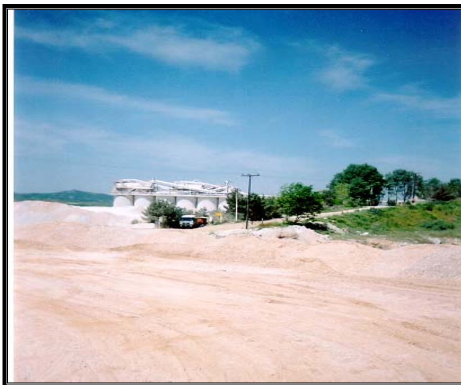
Φωτ. 5. Κτιριακές εγκαταστάσεις.
