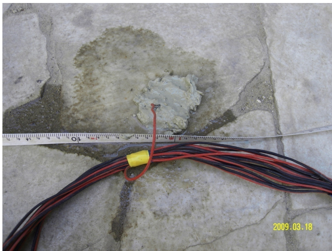
Εικόνα 2.6.2 Ηλεκτρόδιο επαφής και το μίγμα μπεντονίτη που τοποθετείται μεταξύ του ηλεκτροδίου και της επιφάνειας
