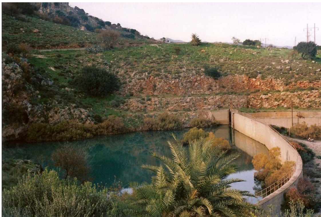
Εικόνα 1: Άποψη του φράγματος της πηγής Αλμυρού.
