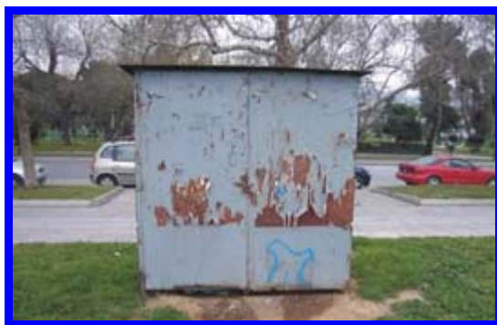
Γεώτρηση 18 στο ύπαιθρο
