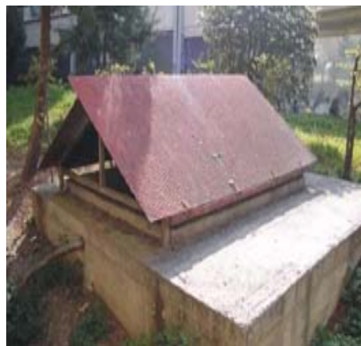
Γεώτρηση 11 στο ύπαιθρο
