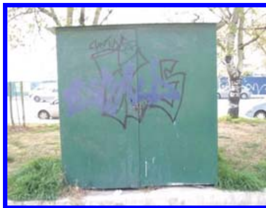
Γεώτρηση 7 στο ύπαιθρο
