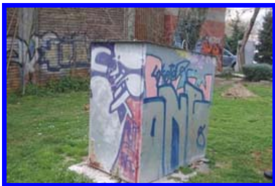
Γεώτρηση 16 στο ύπαιθρο
