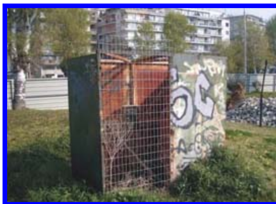
Γεώτρηση 8 στο ύπαιθρο
