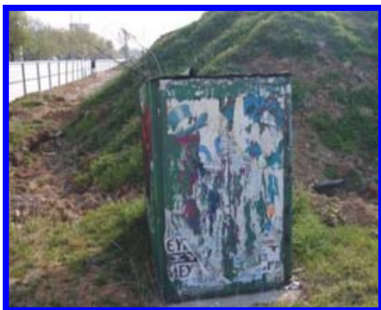
Γεώτρηση 6 στο ύπαιθρο
