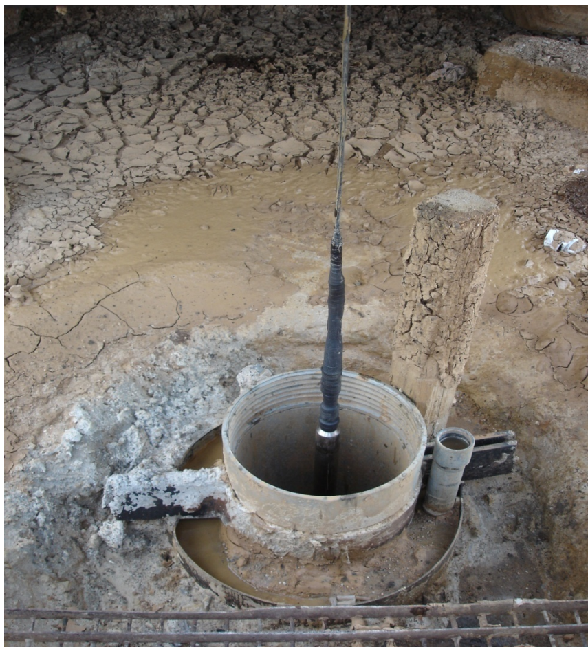
Μέτρηση του βάθους διάτρησης
