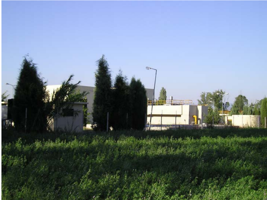
Φωτ. 2.5.2.4. Ο βιολογικός καθαρισμός που βρίσκεται στον Λαγκαδά.
