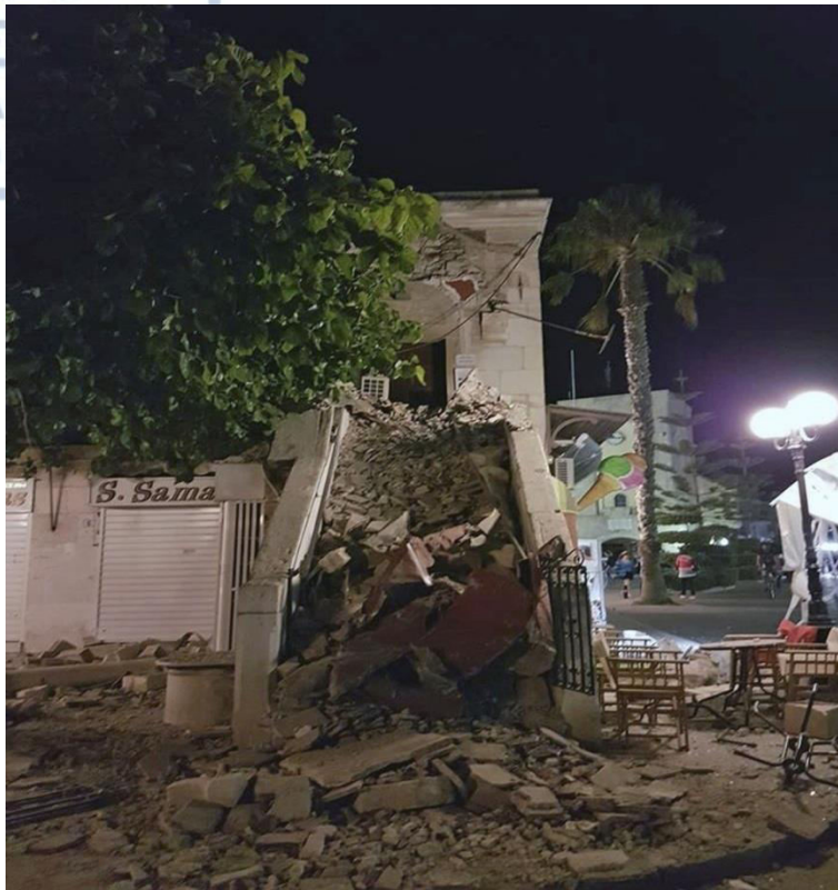
Εικόνα 3 Καταστροφή κτιρίου ( http://www.enikos.gr/society/527218/50-sygklonistikes-photo-apo-ton-foniko-seismo-stin-ko )
