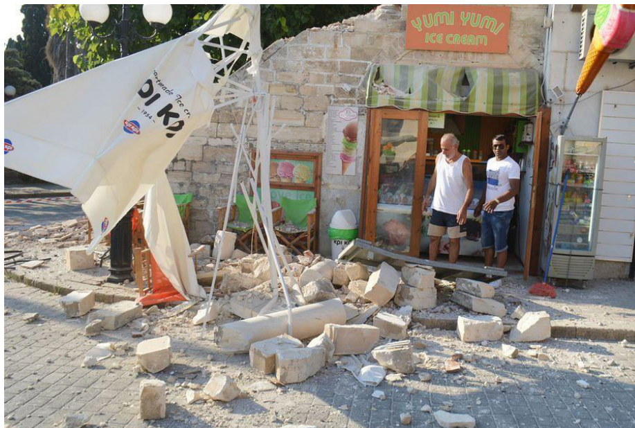
Εικόνα 2 Μερική κατάρρευση σε επιχείρηση ( http://www.documentonews.gr/article/kws-anathewrhthhke-sta-66-rixter-o-seismos-2-toyristes-nekroi-dekades-traymatiesmegales-zhmies-video-photos )
