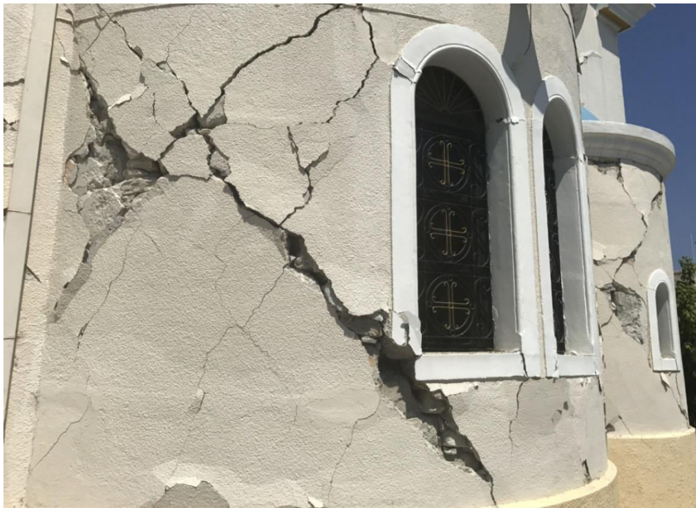
Εικόνα 6 Ρηγματώσεις σε Ναό ( http://www.documentonews.gr/article/kws-anathewrhthhke-sta-66-rixter-o-seismos-2-toyristes-nekroi-dekades-traymaties-megales-zhmies-video-photos )
