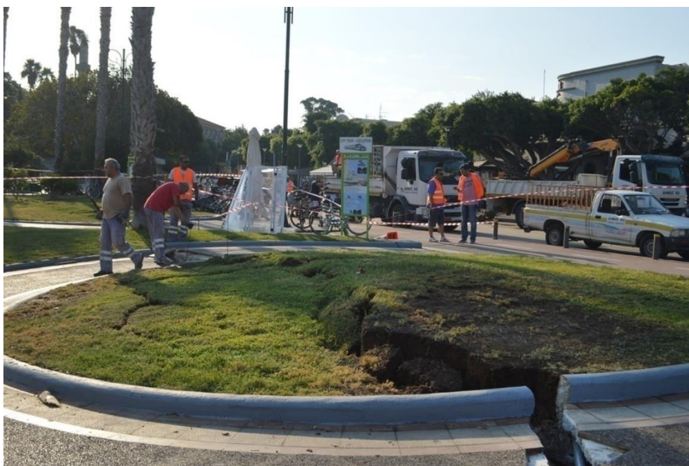
Εικόνα 16 Μεγάλη ρηγμάτωση σε δρόμο της Κω ( http://www.enikos.gr/society/527218/50-syglyklonistikes-photo-apo-ton-foniko-seismo-stin-ko )
