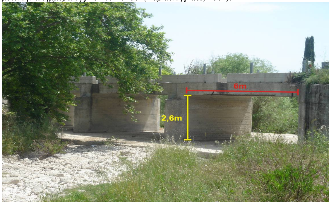
Φωτ. 5.3β Διαστάσεις της γέφυρας του χειμάρρου Μυτιληνιού στην περιοχή «Μεσόκαμπος»
