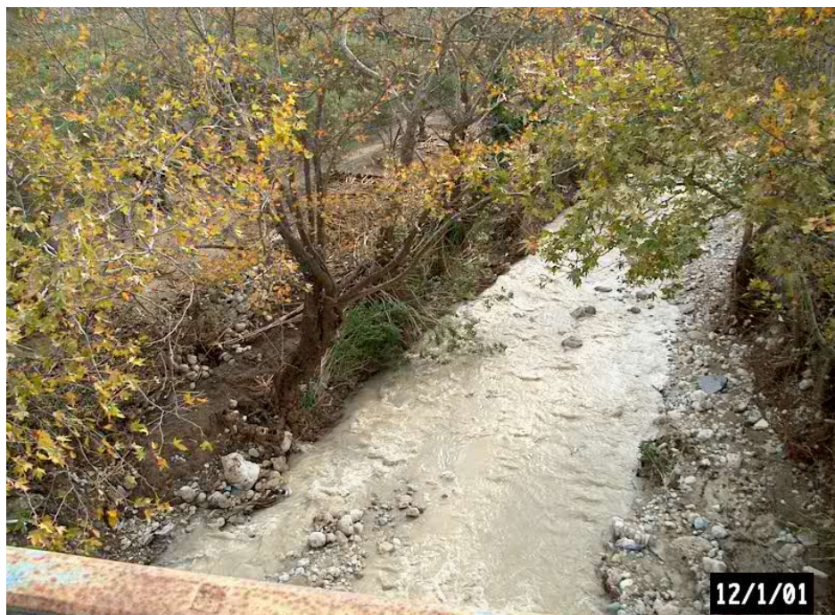
Φωτ.5.8α Ο χείμαρρος Αμφίλυσος στη γέφυρα του Πύργου (Δ.Δ Πύργου – Δήμος Πυθαγορείου) στον κεντρικό δρόμο, μετά την πλημμύρα της 28-29/11/2001 (Βαβλιάκης κ.α., 2002).
