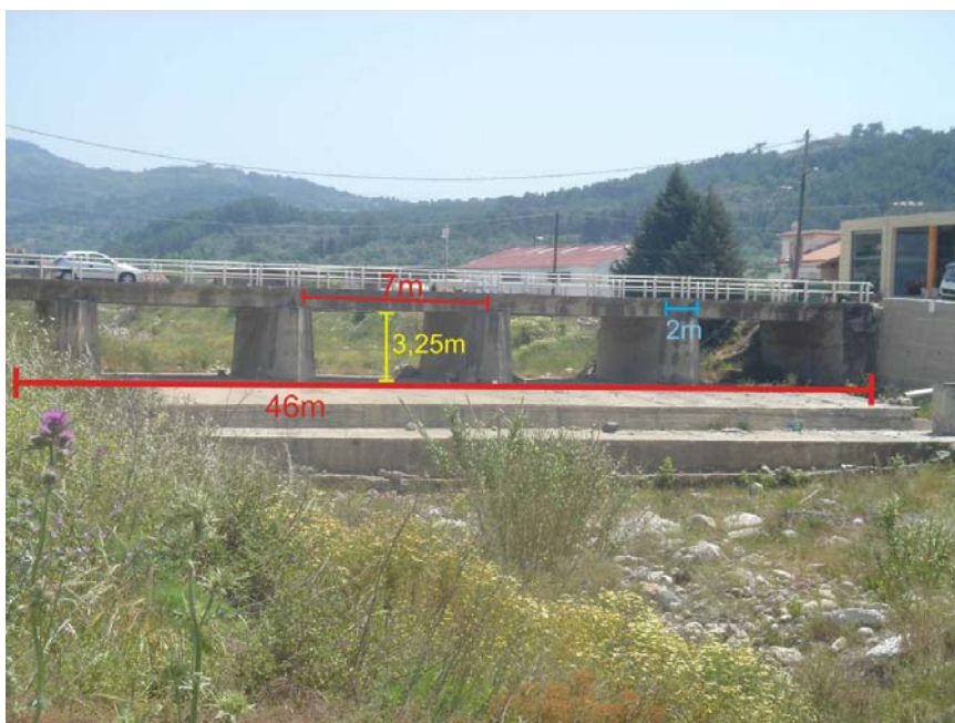
Φωτ. 5.6α Διαστάσεις της γέφυρας του χείμαρρου Φουρνιώτικου στην περιοχή Καρλόβασι.
