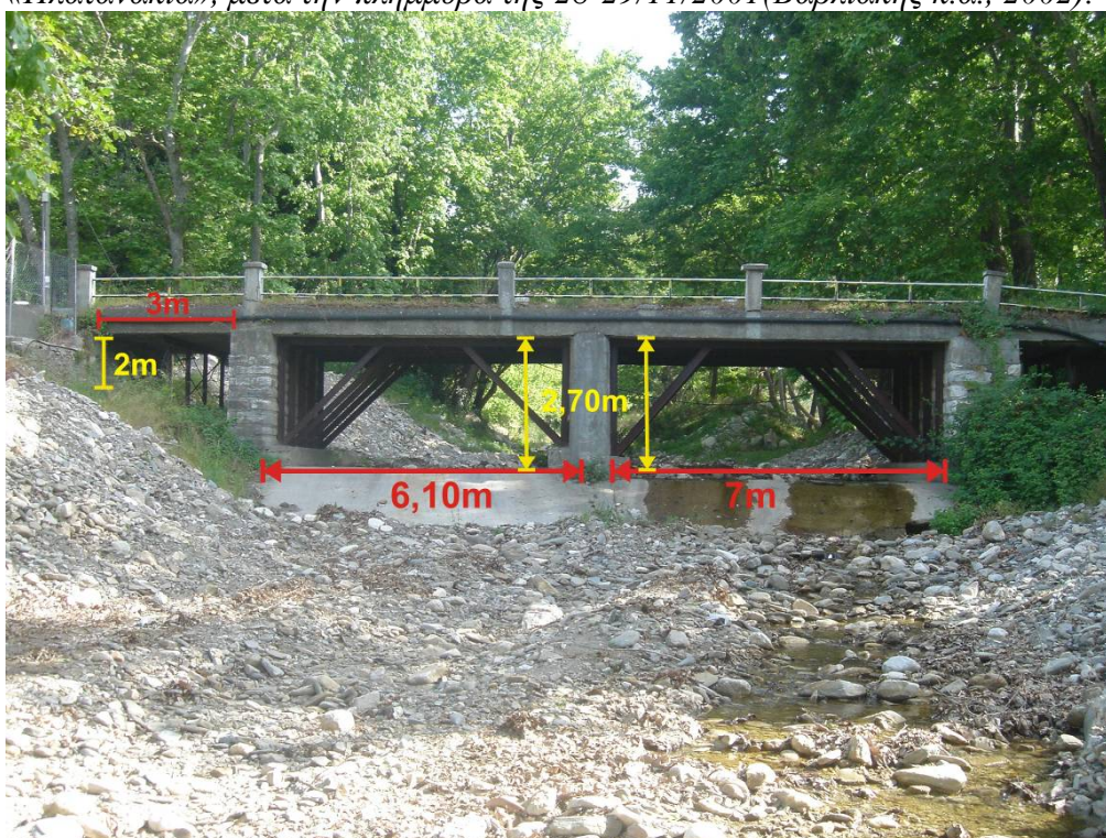
Φωτ. 5.5β Διαστάσεις της γέφυρας του χείμαρρου Κακορέμματος στην περιοχή «Πλατανάκια».
