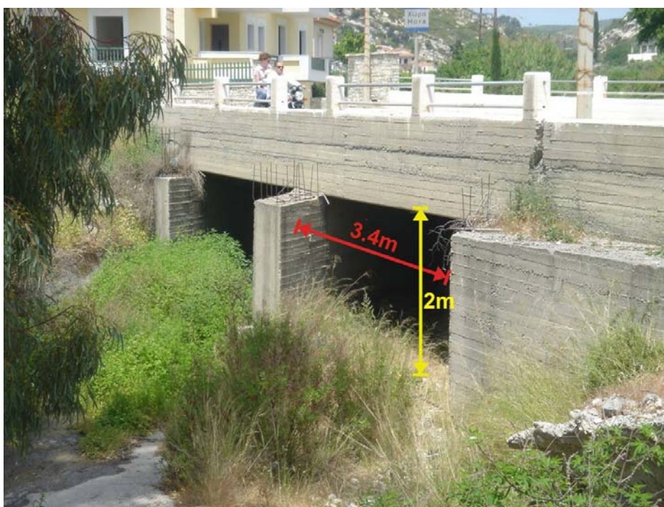
Φωτ. 5.2β Διαστάσεις της γέφυρας του Καλαθή στην είσοδο του Δ.Δ Χώρας (κατάντη πλευρά από το γεφύρι).
