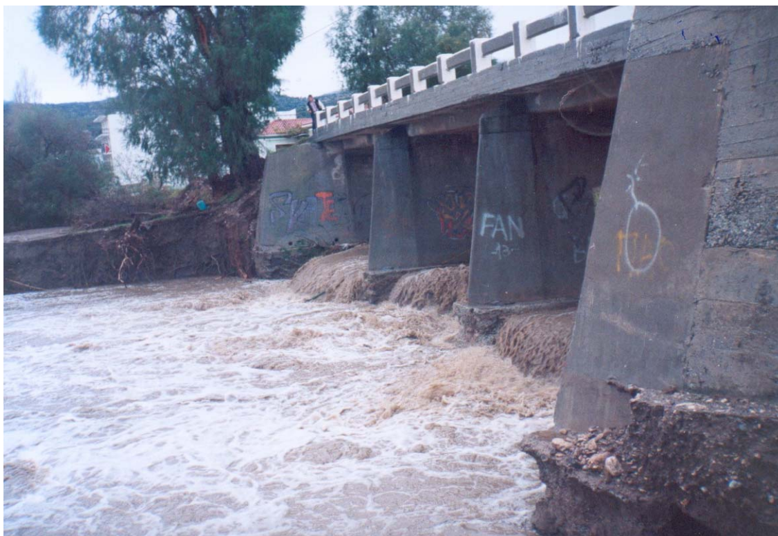
Φωτ. 5.1α Η γέφυρα του Ίμβρασου στο Δ.Δ Ηραίων, με εμφανείς διαβρώσεις όχθης και κοίτης στην κατάντη πλευρά, μετά την πλημμύρα της 28-29/11/2001 (Βαβλιάκης κ.α., 2002).
