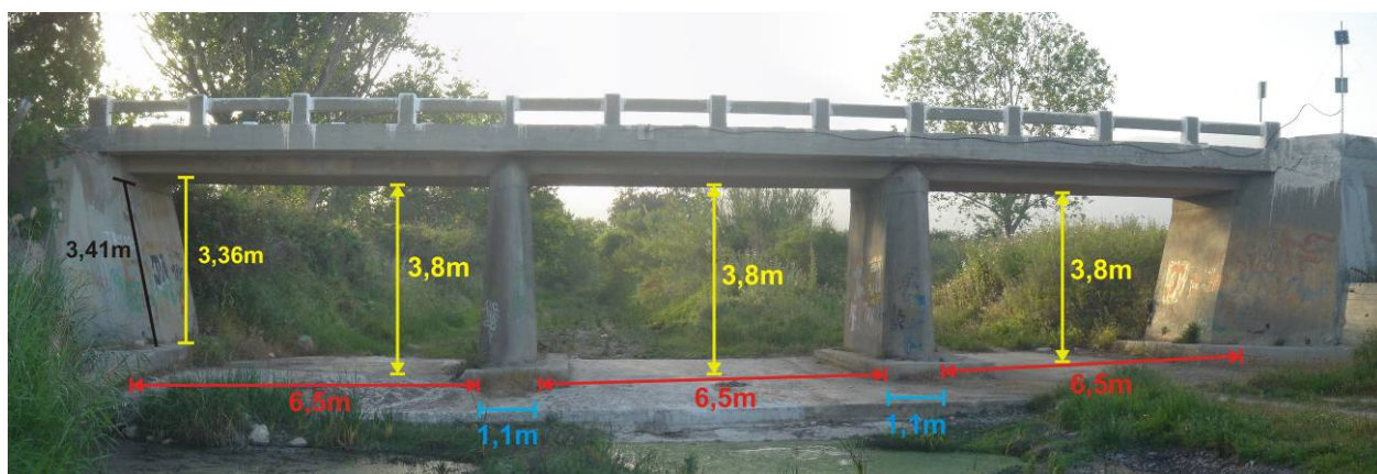
Φωτ. 5.1β Διαστάσεις της γέφυρας του Ίμβρασου στο Δ.Δ Ηραίων
