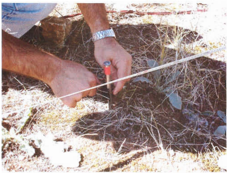
Εικ.8 - Τοποθέτηση χάλκινων ηλεκτροδίων.
