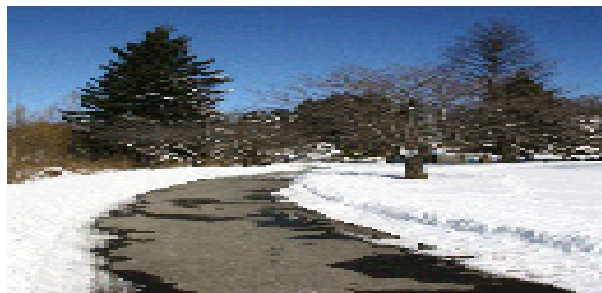
Δρόμος με γεωθερμική αντιπαγετική προστασία ( www.aidengineering.gr )
