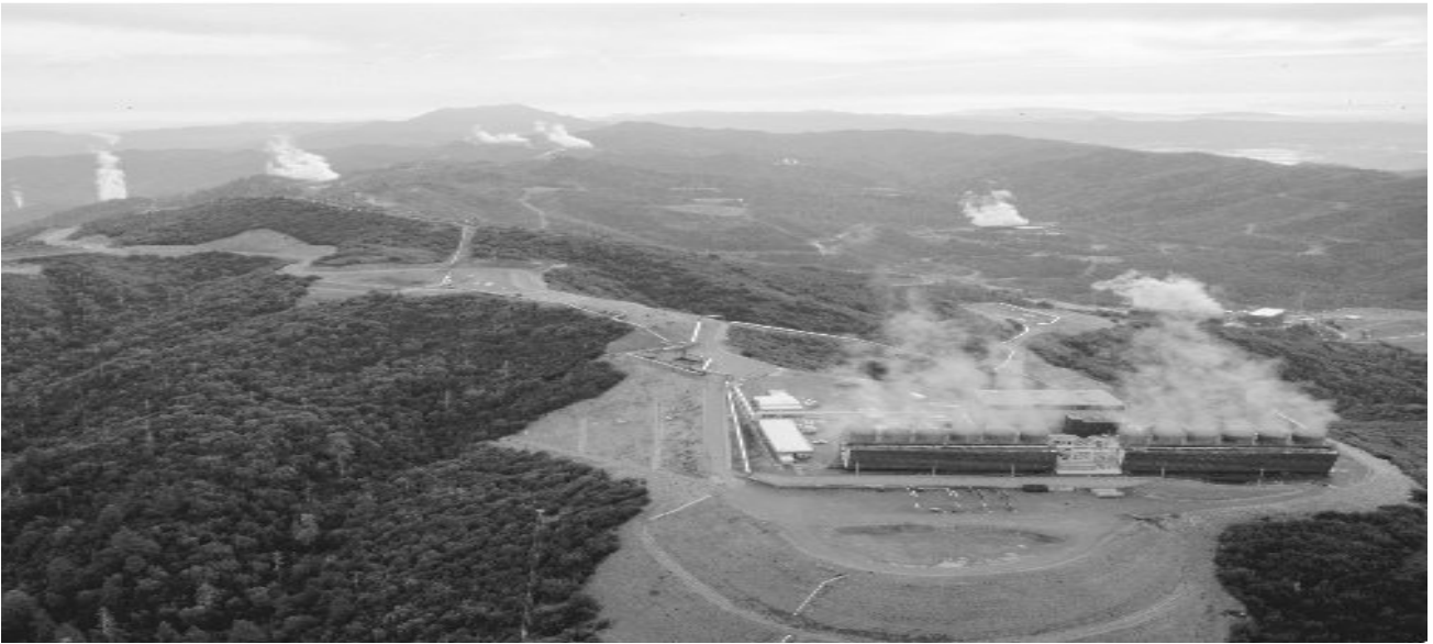
Γεωθερμικό εργοστάσιο ηλεκτροπαραγωγής στο Geyserville, California (google\images\geothermalplans)
