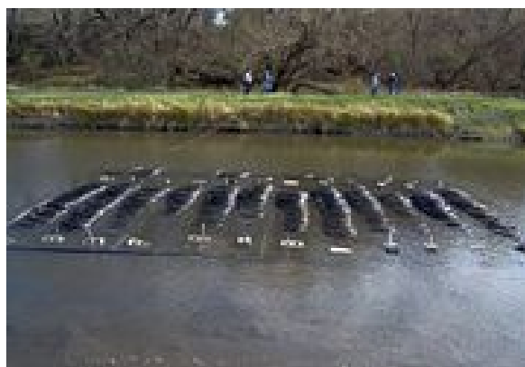
Καταβυθιζόμενοι εναλλάκτες κλειστού κυκλώματος λίμνης ( www.aidengineering.gr / www.Boudouri.gr )
