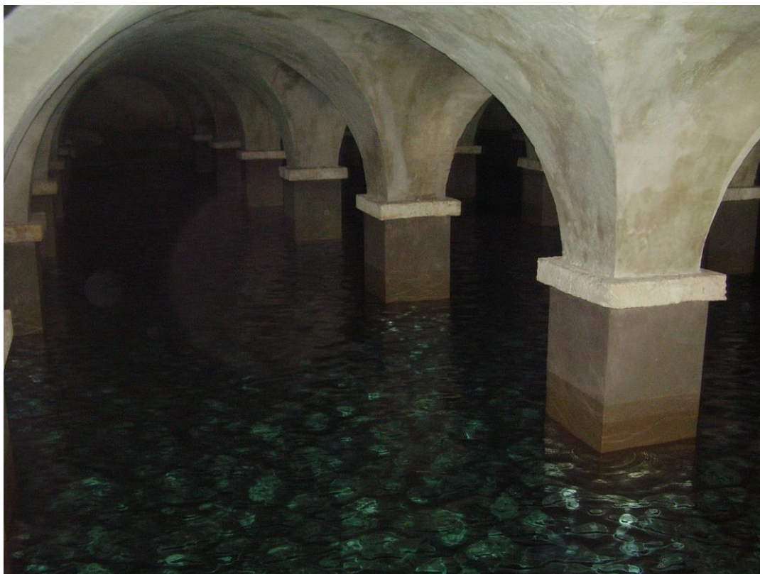
Φωτ. 8.1: Εσωτερική άποψη της Δεξαμενής του Αγίου Ιωάννη
