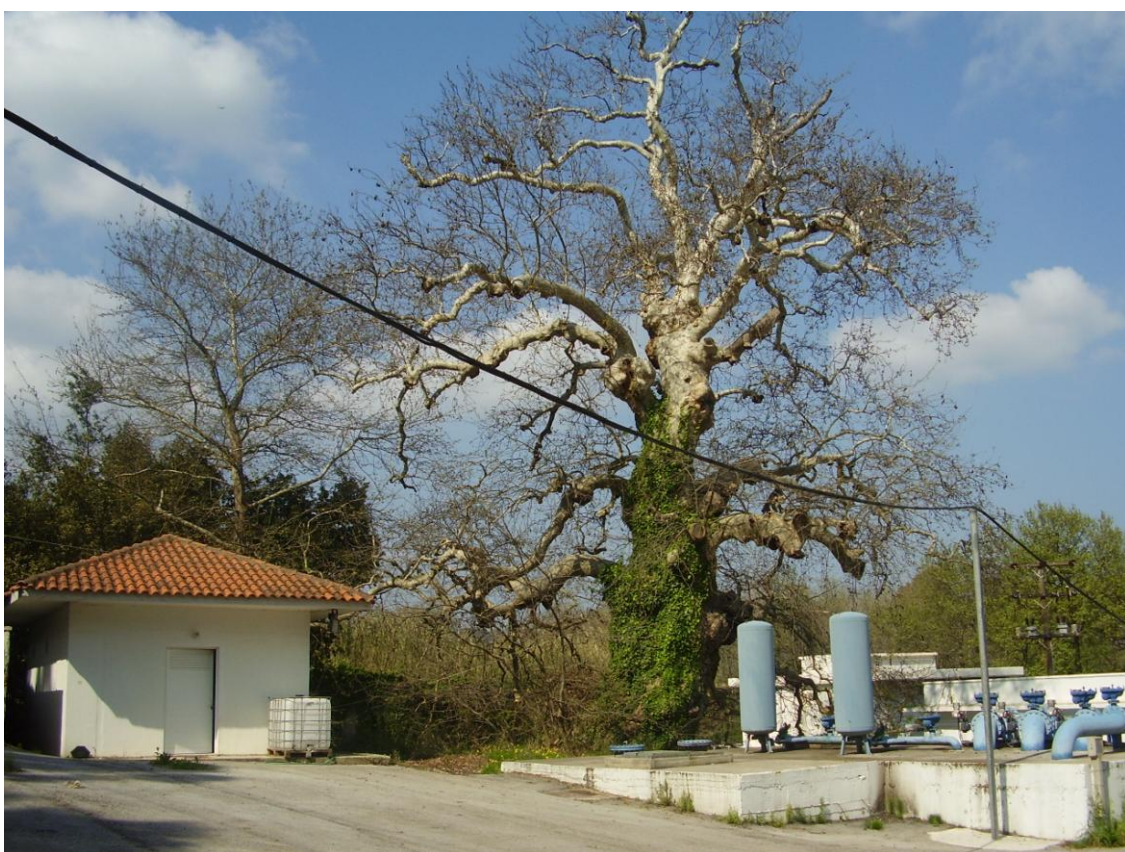
Φωτ. 8.2: Αντλιοστάσιο Αγυιάς
