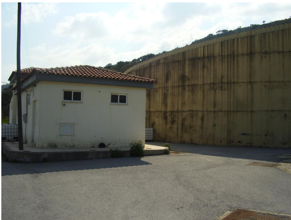
Φωτ. 8.3: Δεξαμενή στο Βαντέ
