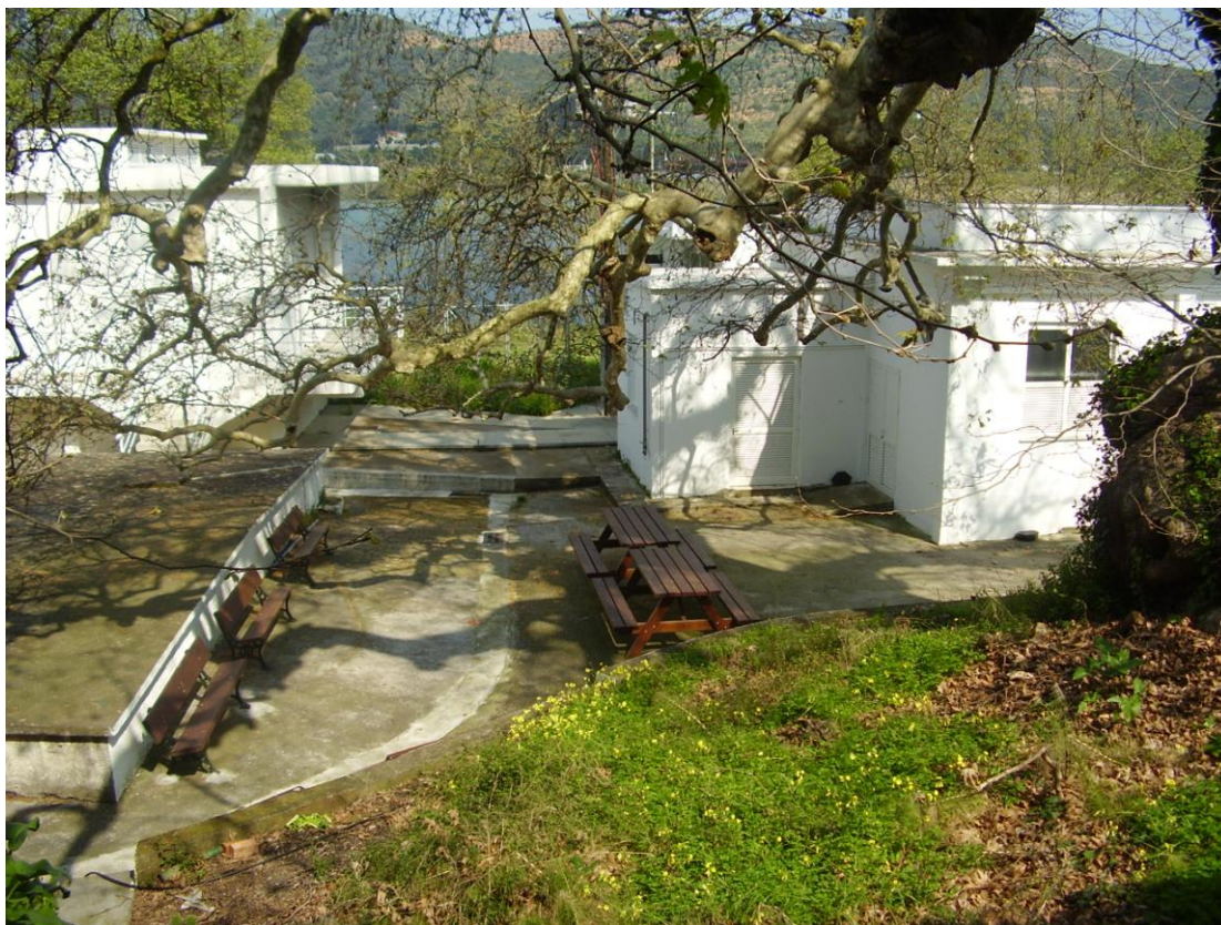
Φωτο. 1: Αντλιοστάσιο Αγιάς
