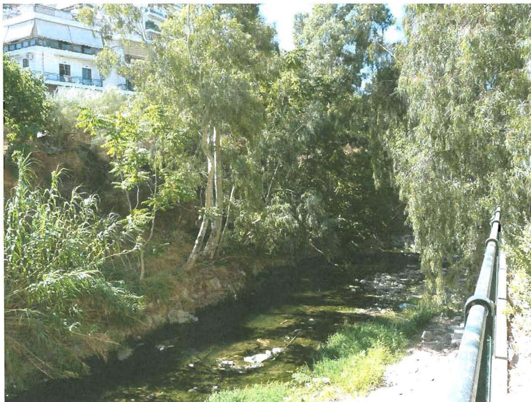
Εικόνα 9. Ρέμα Ποδονίφτης στην περιοχή Χαλανδρίου.
