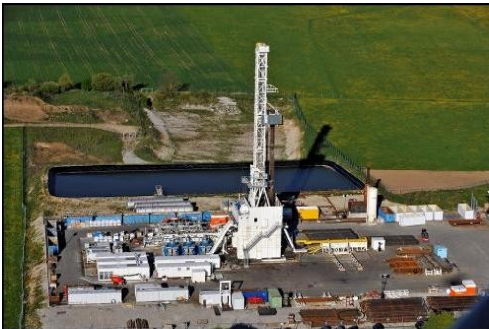
Γεωτρύπανο (drilling rig) στο Mauerstetten, Bayern, Germany
