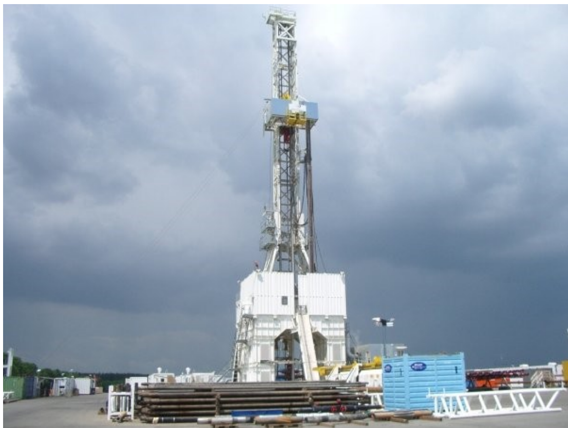
Γεωτρύπανο (drilling rig GT-1)
