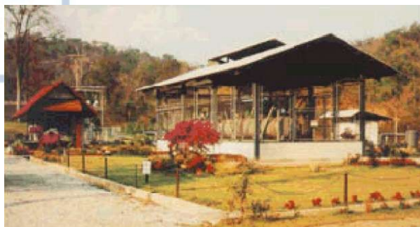
Σχήμα 7. Ο μικρός (300 kW) πολυσυναρτησιακός δυαδικός σταθμός ηλεκτροπαραγωγής στο Fang (Ταϊλάνδη)
