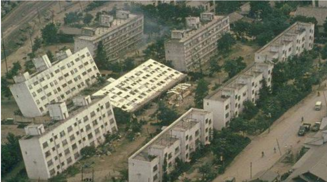
Εικόνα 1: Αποτελέσματα ρευστοποίησης του εδάφους σε κατασκευές της πόλης Niigata Ιαπωνίας, λόγω σεισμού της 16ης Ιουνίου 1964 με μέγεθος M=7,5 (Google image).
