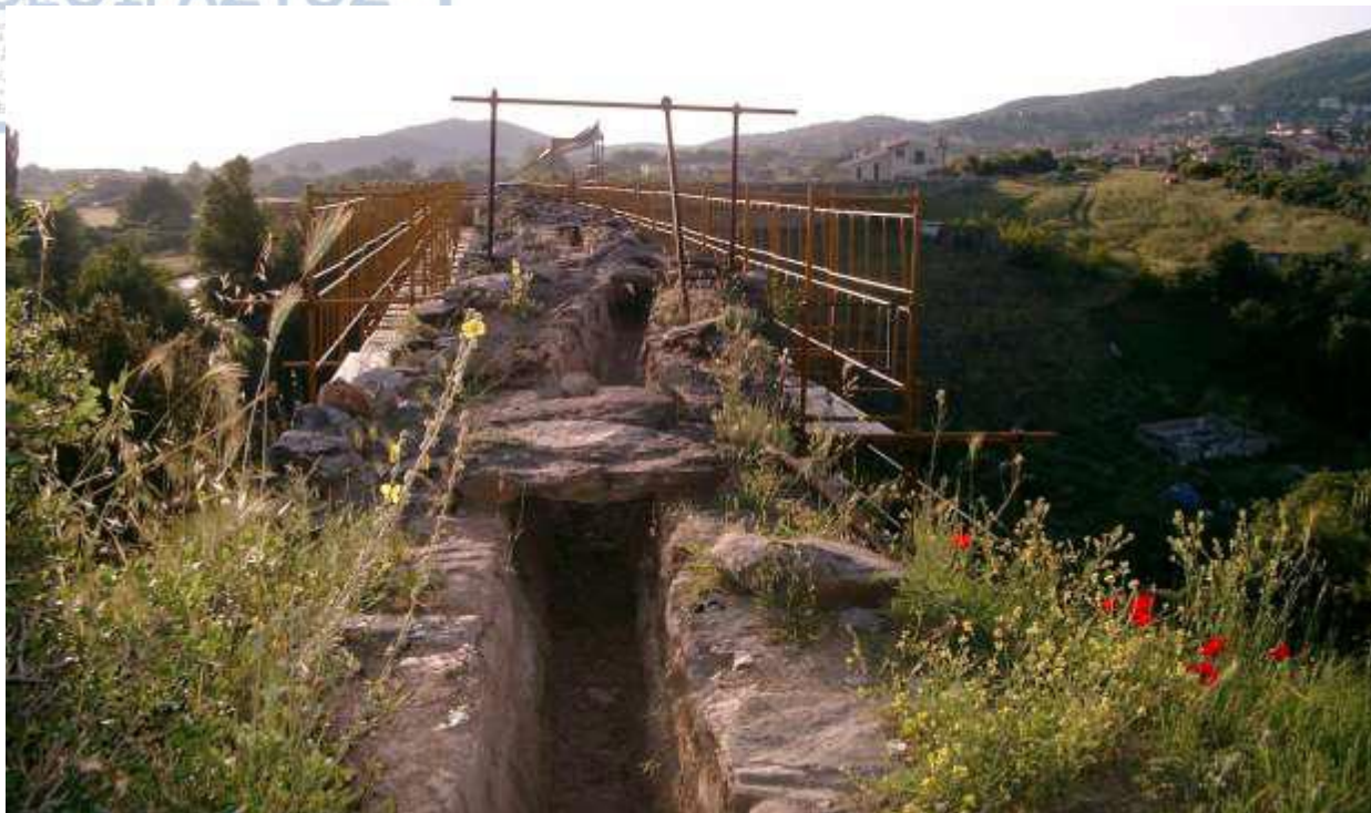
Εικόνα 41 Ο αγωγός πάνω στην υδατογέφυρα (Γκαλά-Γεωργιά 2015).
