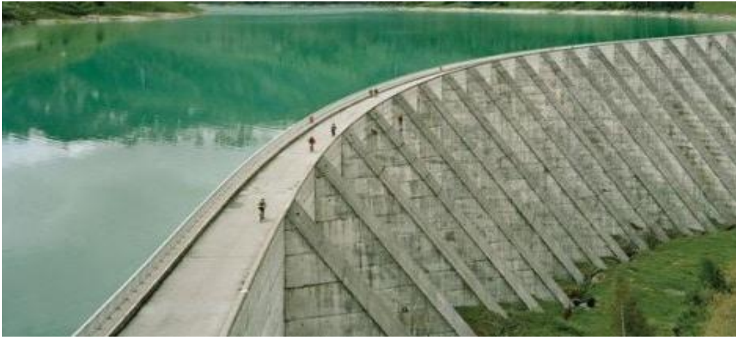
Εικόνα 15 Στέψη αντηριδωτού φράγματος ( https://theconstructor.org/water-resources/types-buttress-dams-functions-applications/17359/ ).
