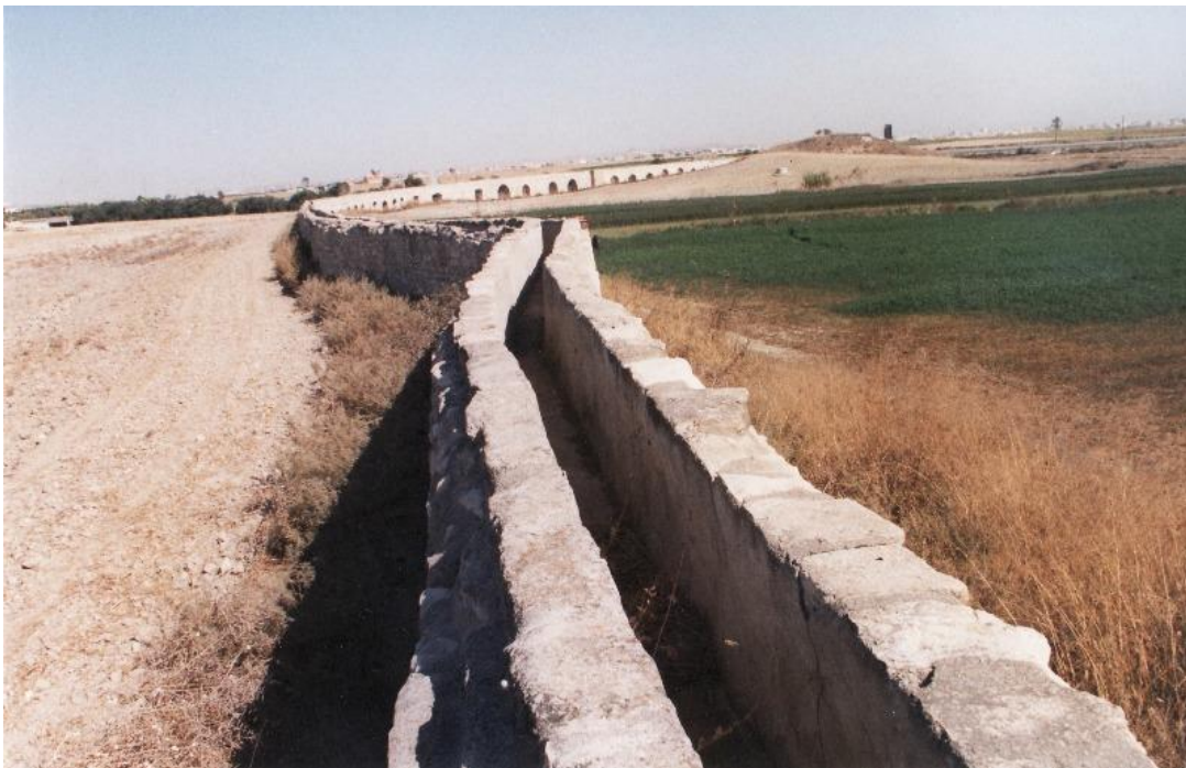
Εικόνα 3 Ανοιχτό κανάλι για την μεταφορά νερού στην Λάρνακα (Μιχαηλίδης 2009 ).
