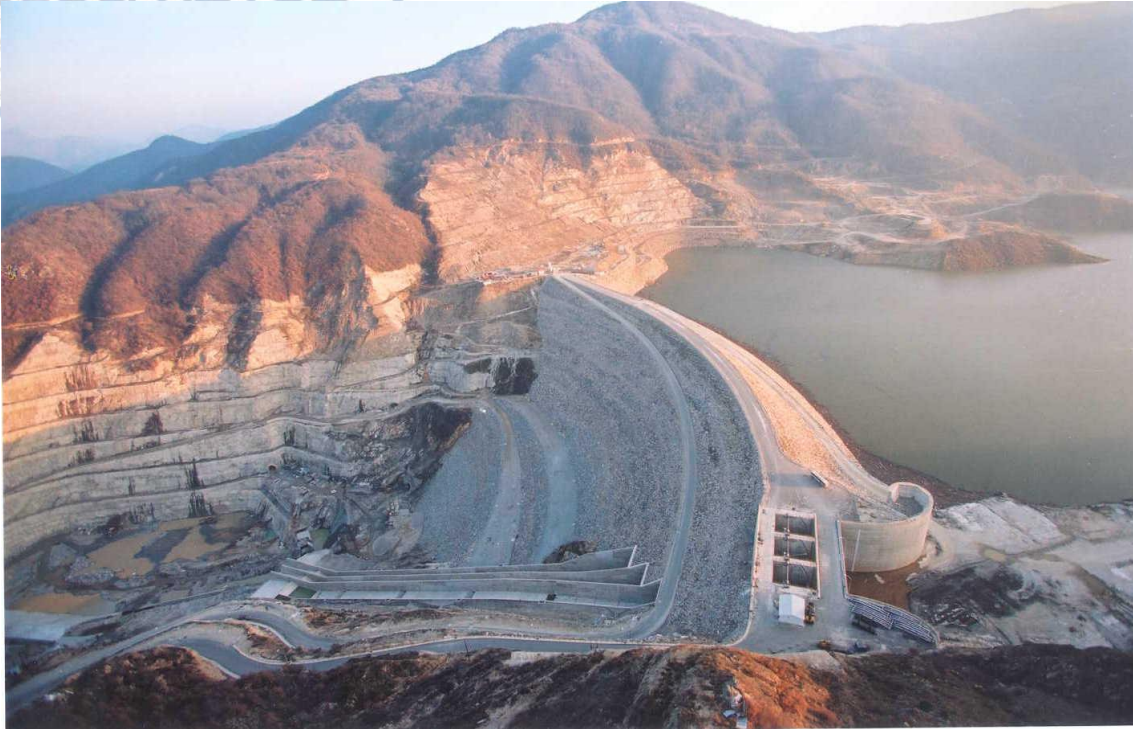
Εικόνα 32 Φράγμα Θησαυρού απεικονίζεται ο ταμιευτήρας στα δεξιά τα δύο αντερείσματα καθώς και οι χωματουργικές διαδικασίες που έχουν γίνει κατάντη του φράγματος (ΑΚΤΟΡ).
