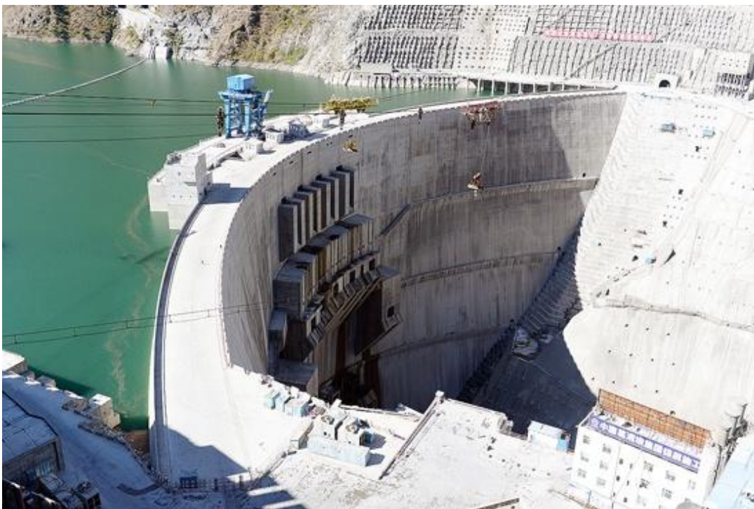
Εικόνα 49 Υδροηλεκτρικός σταθμός του φράγματος Jinping-I (China Gezhouba Group Co., LTD 2014).
