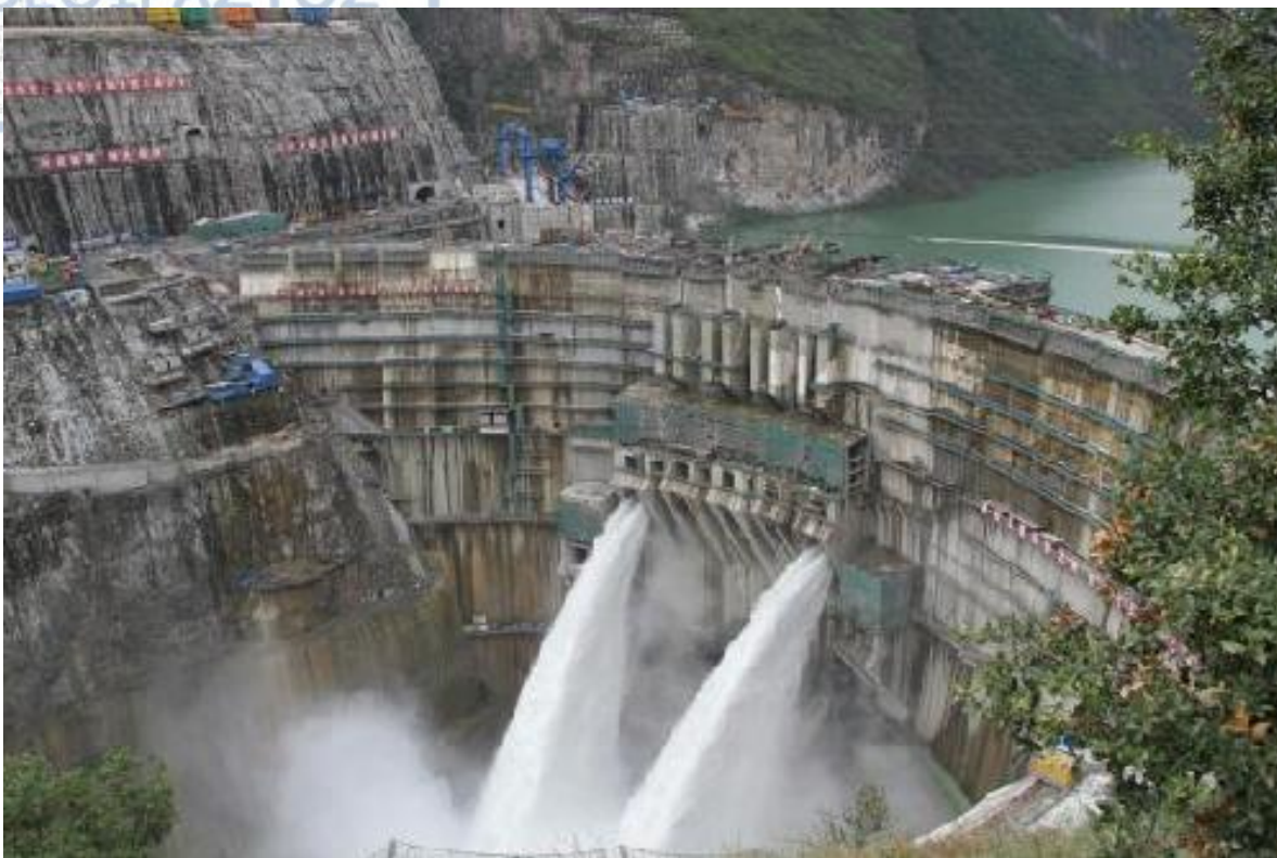
Εικόνα 48 Το φράγμα Jinping-I (PowerChina 2016).
