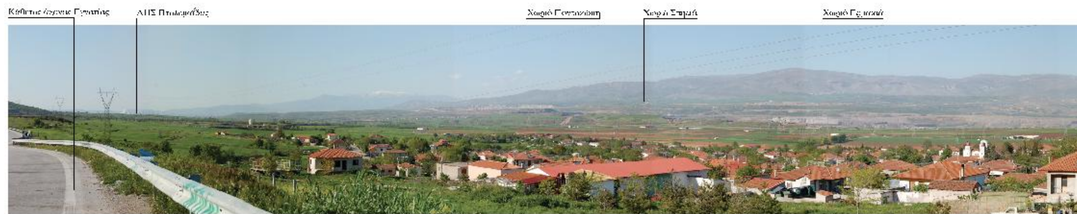
VP1 - ΒΑ. Χωριό Ποντοκόμη. Υφιστάμενη κατάσταση 2009
