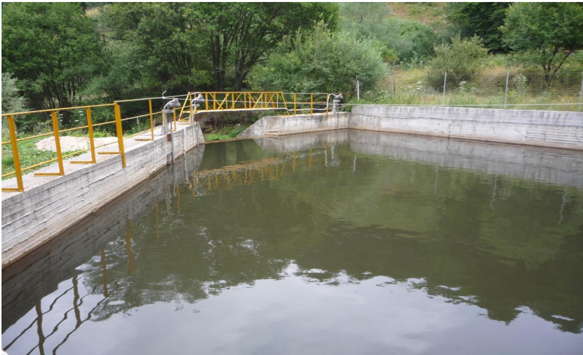
Εικόνα 4: Φράγμα ανακοπής ροής.
