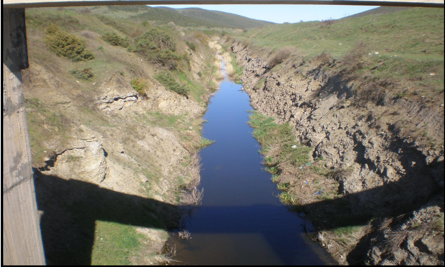
Εικ.Α.1.15.Ανθρωπογενές κανάλι αποστράγγισης. (Φωτο.: Γ.Ευσταθίου 2010).
