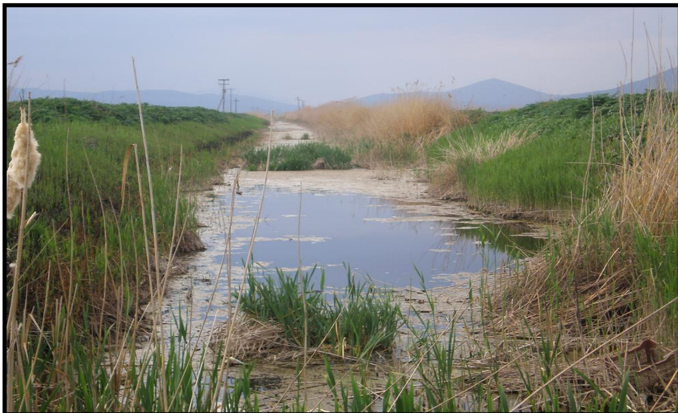
Σχ. 5.4. Κεντρικό κανάλι αποστράγγισης της λεκάνης της Ξυνιάδας (Ευσταθίου Γιώργος, 2010).
