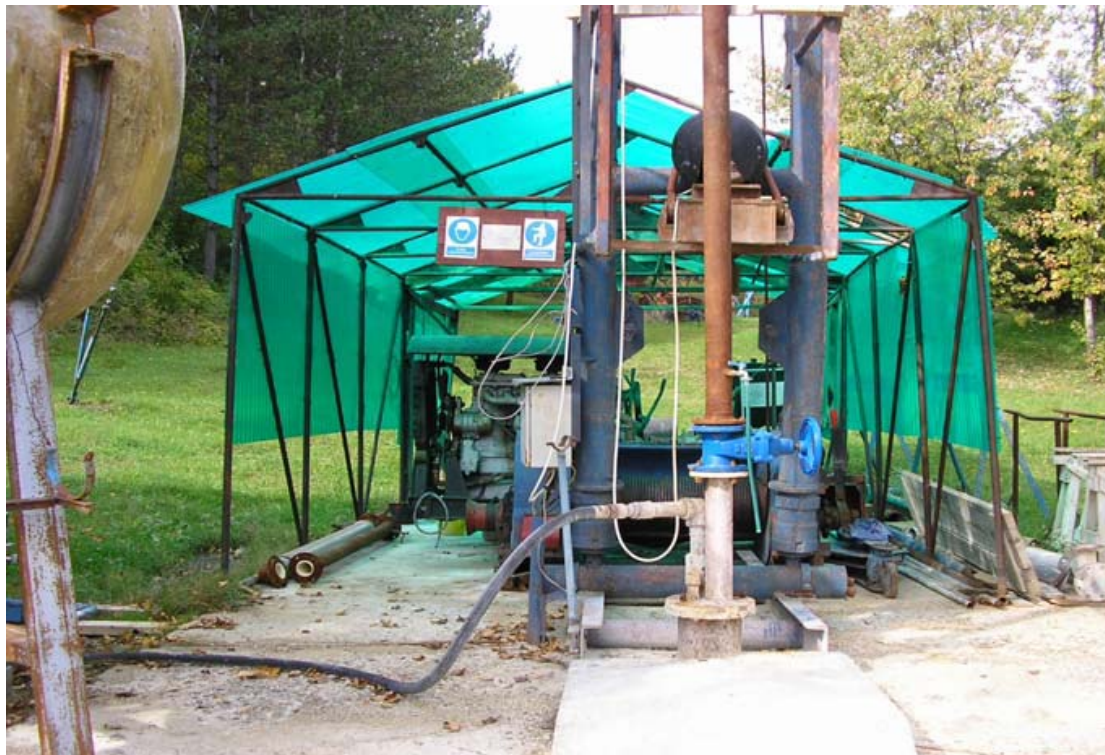
Φωτ. 1 Διάνοιξη θερμής γεώτρησης στην πόλη Kistelek
