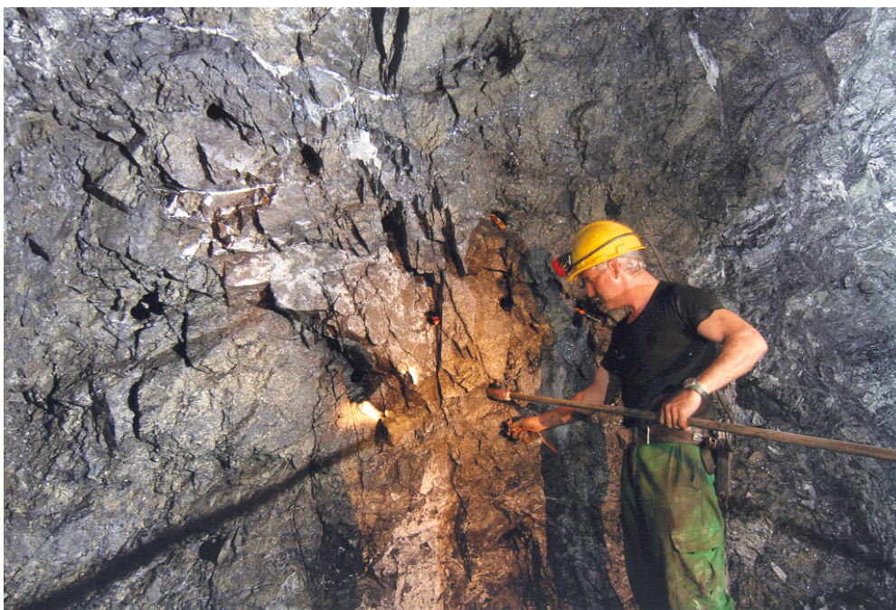
Εικ.3: Εργασίες στον εσωτερικό χώρο του μεταλλείου(τοποθέτηση εκρηκτικών υλών)
