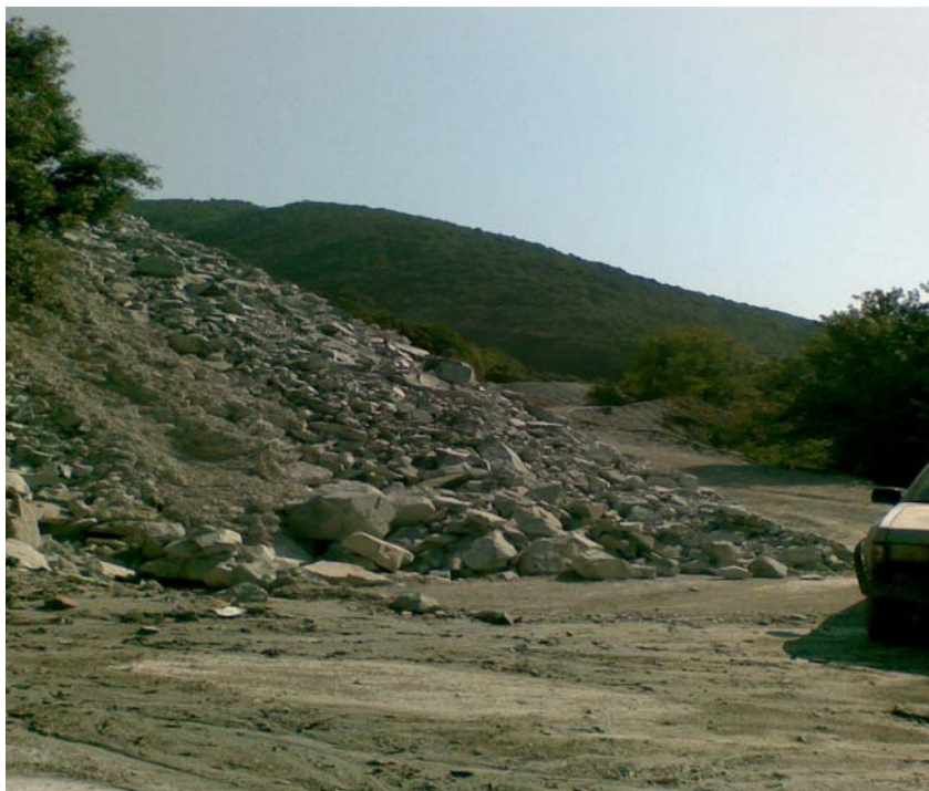
Εικ.4.1.2: Χώρος απόθεσης στεφάνου υλικού
