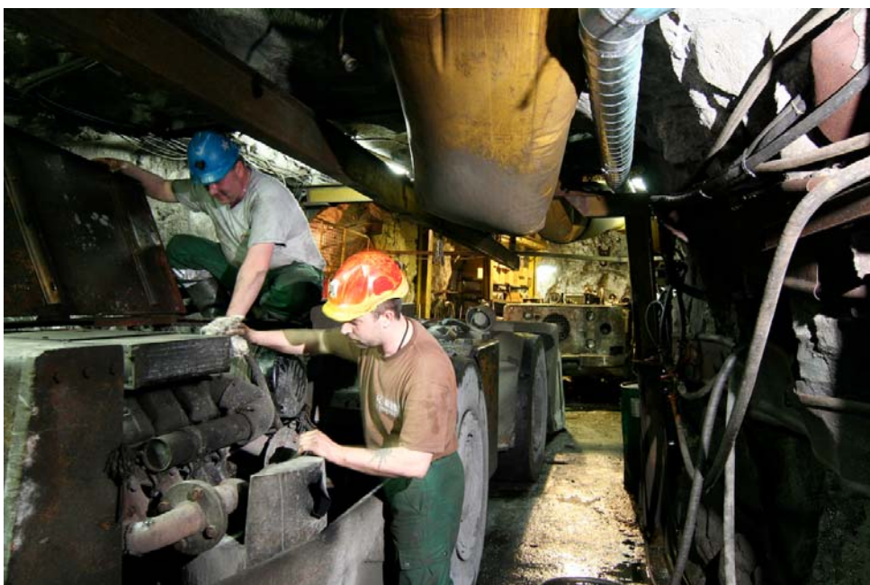
Εικ.7: Εργασίες στον εσωτερικό χώρο του μεταλλείου
