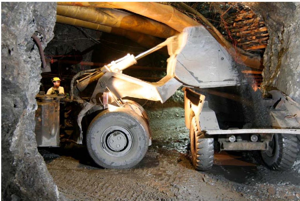
Εικ.5: Εργασίες στον εσωτερικό χώρο του μεταλλείου (φόρτωση του μεταλλεύματος σε φορτηγό)
