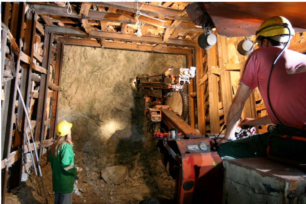
Εικ.8: Εργασίες στον εσωτερικό χώρο του μεταλλείου
