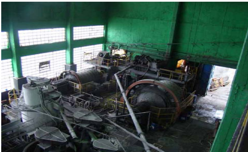
Εικ.11: Εσωτερικός χώρος του εργοστασίου εμπλουτισμού
