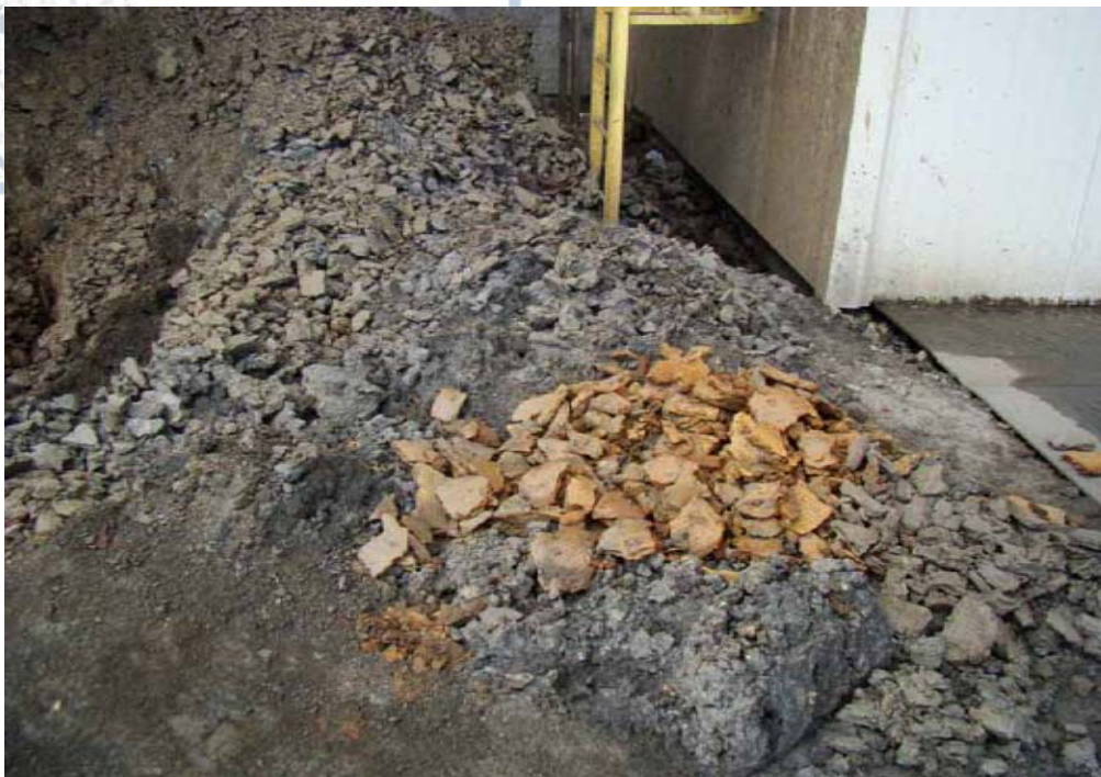
Εικ.14: Υλικό που οδηγείται στον χώρο απόθεσης στερεών καταλοίπων
