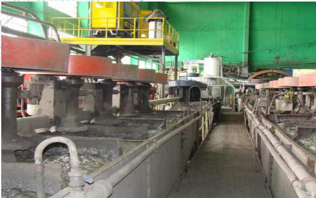
Εικ.10: Εσωτερικός χώρος του εργοστασίου εμπλουτισμού
