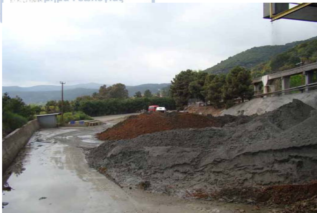
Εικ.20: Υλικό λιθογόμωσης
