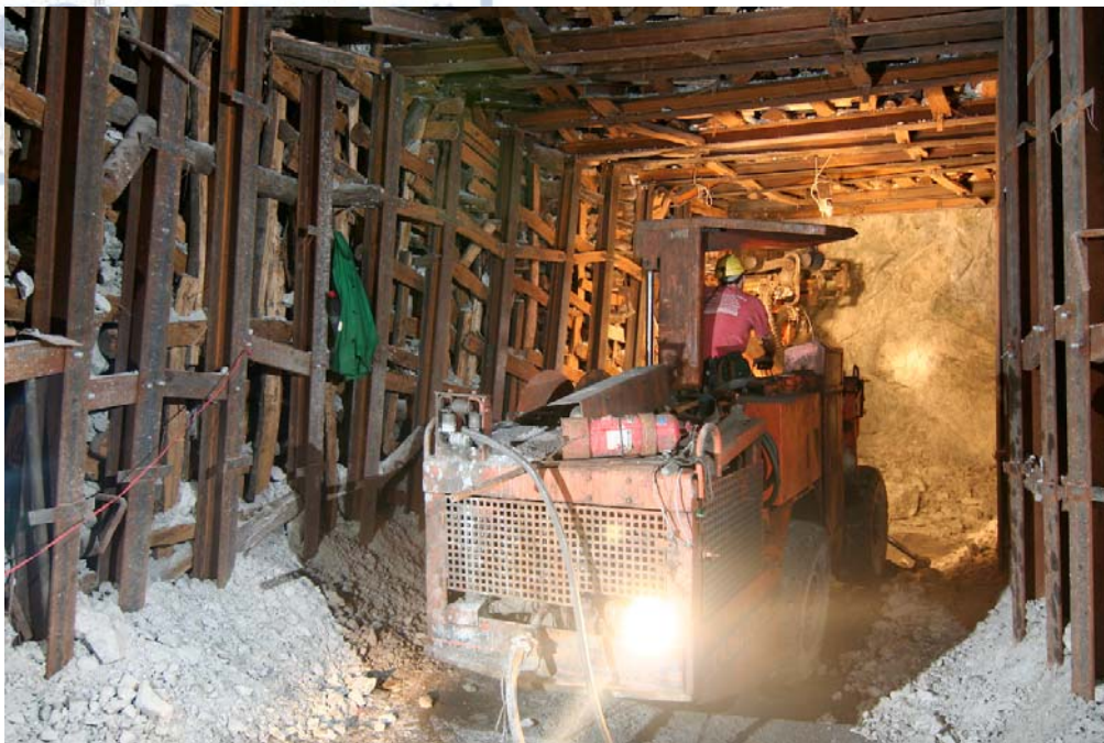
Εικ.4: Εργασίες στον εσωτερικό χώρο του μεταλλείου
