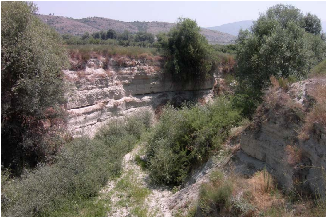
Εικόνα 34 : Άποψη του ρέματος που εκβάλλει στην περιοχή του τζαμιού. Ορατή είναι η κατά βάθος διάβρωση λόγω της πτώσης του βασικού επιπέδου από τη υποχώρηση της λίμνης.
