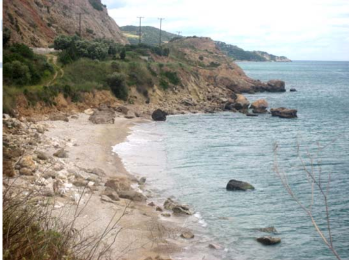
Εικ.6 Περιοχή κατολίσθησης
