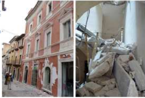
Σχήμα 2.15 Η εξωτερική πλευρά (αριστερά) ενός πλινθόκτιστου κτιρίου και το εσωτερικό του μέρος (δεξιά) που έχει καταρρεύσει (Bazzurro et al., 2009).
