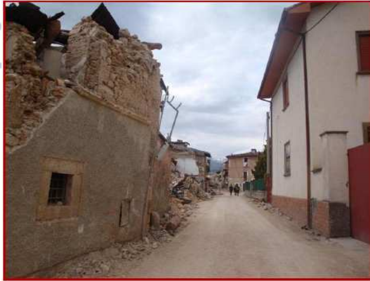
Σχήμα 2.6 Ένα πλινθόκτιστο κτίριο στην Onna που έχει εν μέρει καταρρεύσει (αριστερά) και ένα κτίριο οπλισμένου σκυροδέματος με αμελητέες ζημιές (δεξιά) (Rossetto et al., 2009).
