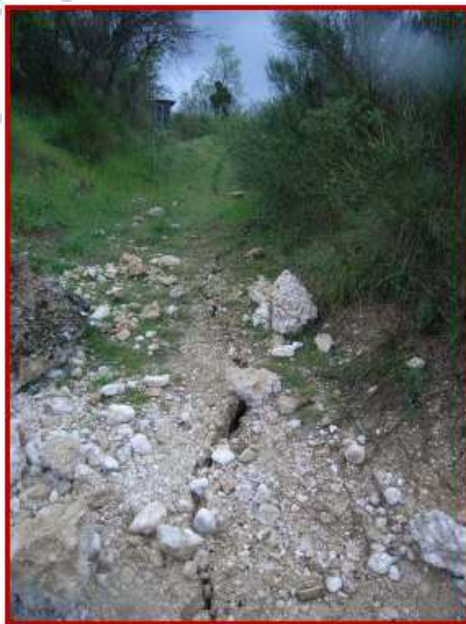
Σχήμα 2.8 Ρωγμή σε λοφοπλαγιά πάνω από τη Paganica (Rossetto et al., 2009).
