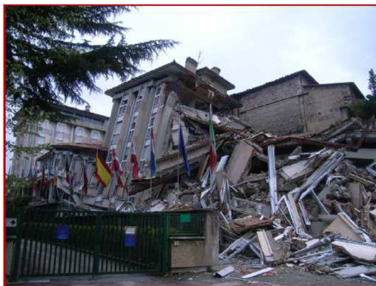
Σχήμα 2.12 Μερική κατάρρευση στο ξενοδοχείο Hotel Degli Abruzzi (Rossetto et al., 2009).
