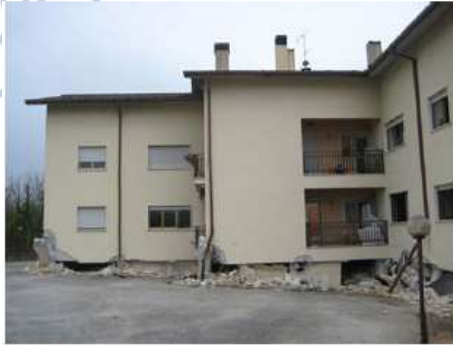
Σχήμα 2.4 Μερικές καταρρεύσεις πάνω σε μαλακό έδαφος στο Pettino (Bazzurro et al., 2009).
