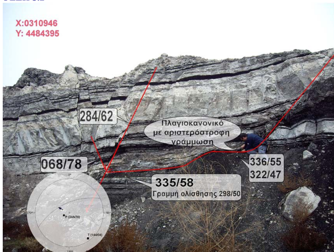
. Εικόνα 3.2. Ζώνη ρηγμάτων και οι άξονες παραμόρφωσης του πλαγιοκανονικού ρήγματος με P: 245/70 και T: 144/04.
