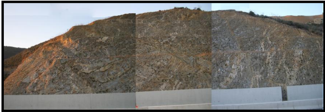
Εικόνα 5.4.7: Όρυγμα περί τη Χ.Θ. 13+500
