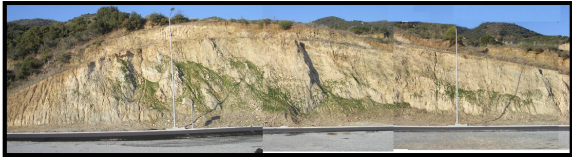
Εικόνα 5.4.1: Όρυγμα περί τη Χ.Θ. 11+000
