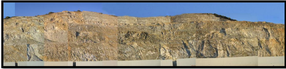
Εικόνα 5.4.4: Όρυγμα περί τη Χ.Θ. 11+900
