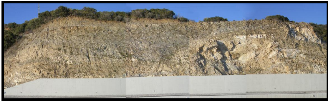
Εικόνα 5.4.3: Όρυγμα περί τη Χ.Θ. 11+700
