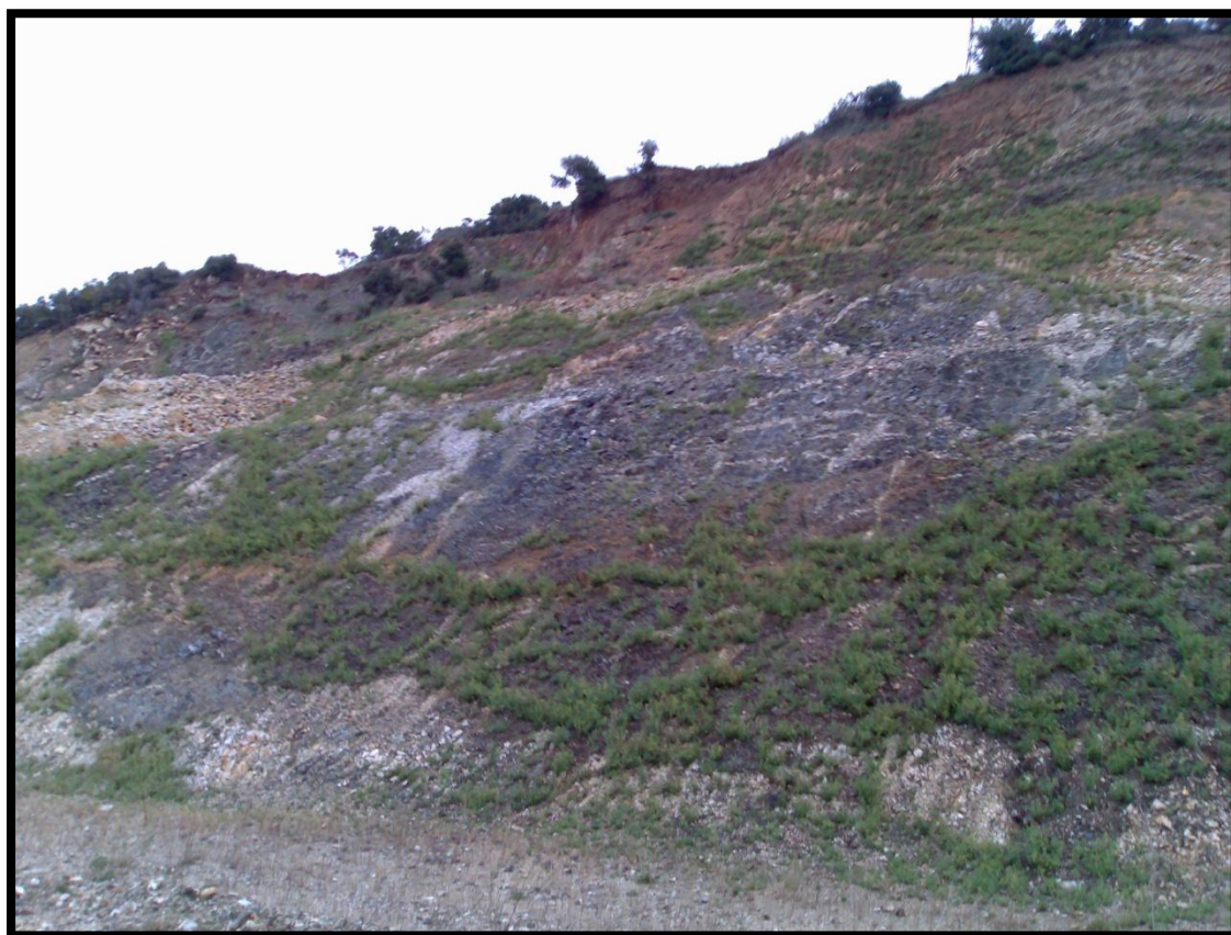
Εικόνα 5.2.5: Όρυγμα περί τη Χ.Θ. 10+800
