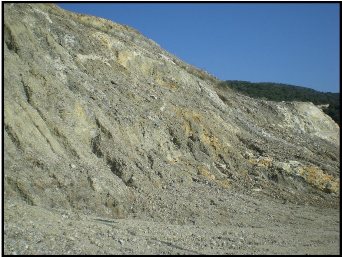
Εικόνα 5.2.1: Άποψη του ορύγματος περί τη Χ.Θ. 9+700 τον Απρίλιο του 2006
