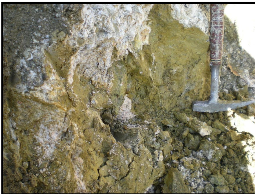
Εικόνα 5.1.3: Χαρακτηριστική εικόνα αργιλοποιημένης ζώνης της Ενότητας C στο όρυγμα περί τη Χ.Θ. 9+700
