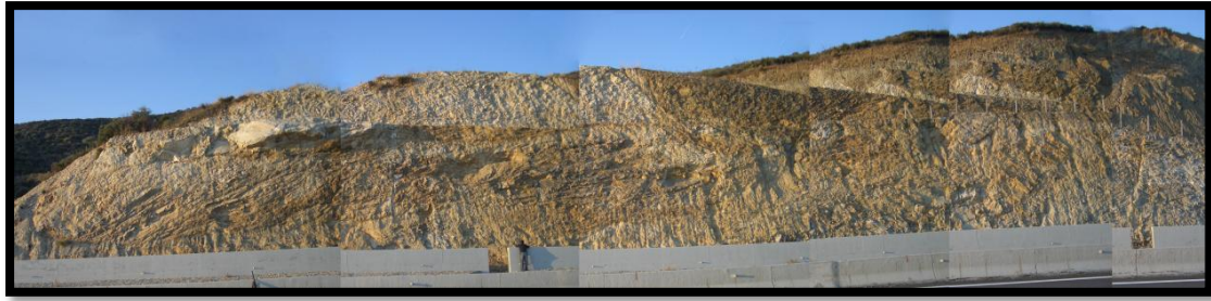
Εικόνα 5.4.5: Όρυγμα περί τη Χ.Θ. 13+000
