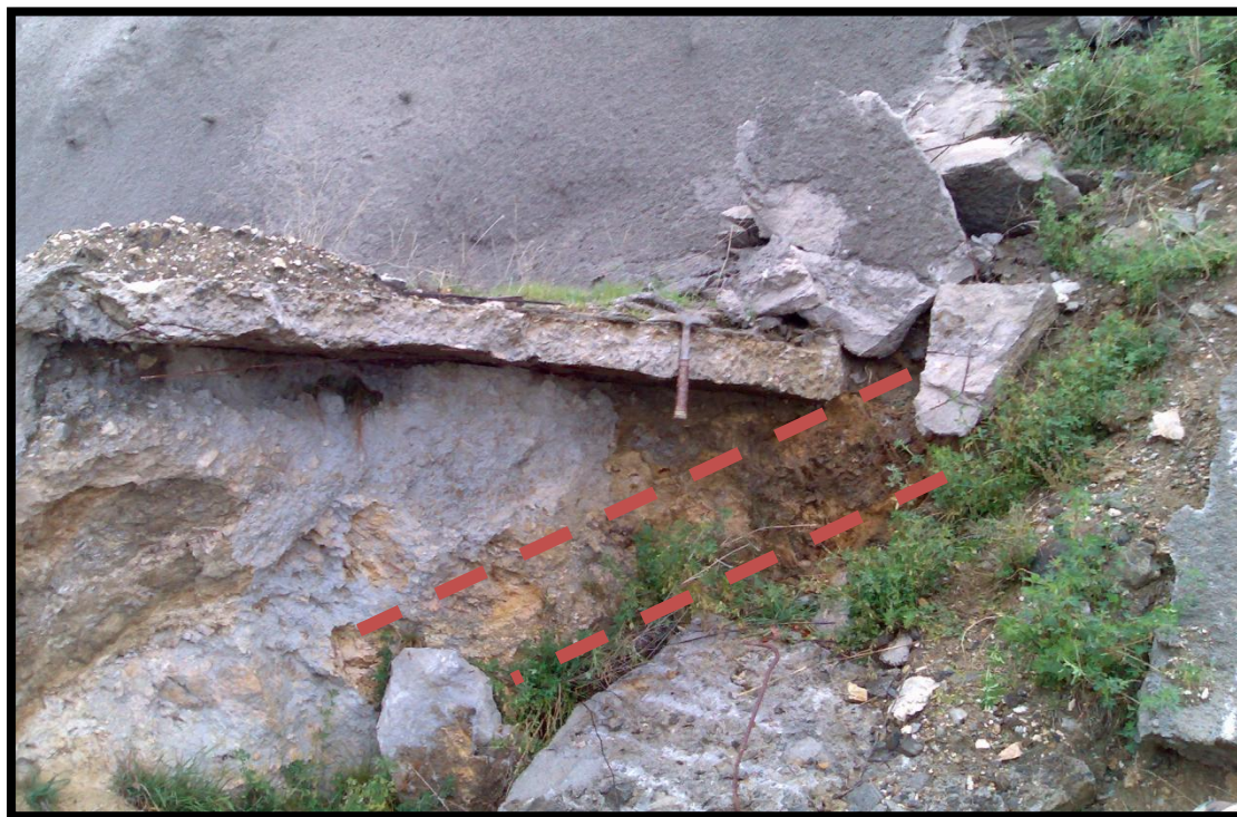
Εικόνα 5.1.4: Αργιλοποιημένη ζώνη εξαλλοίωσης που ελέγχει τη ροή στο σώμα του ορύγματος πίσω από το μέτωπο εκτοξευόμενου σκυροδέματος (Χ.Θ. 10+500)
