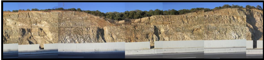
Εικόνα 5.4.2: Όρυγμα περί τη Χ.Θ. 11+400
