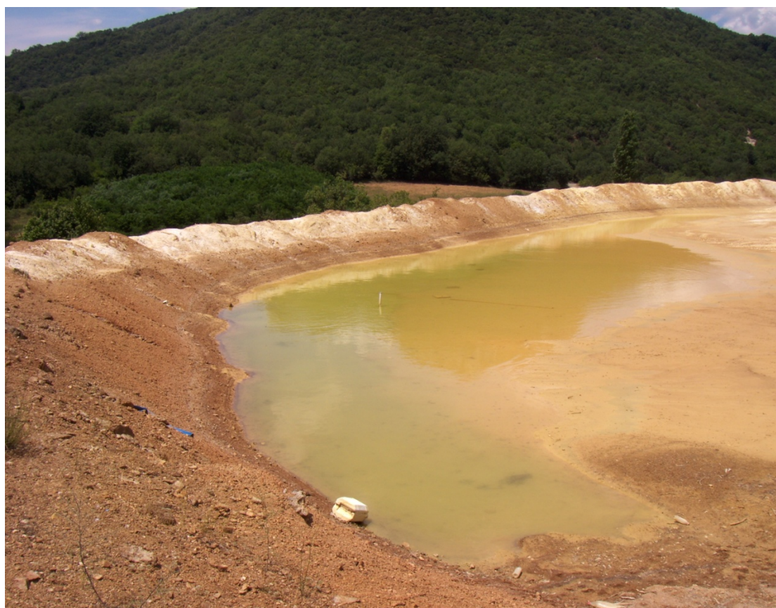
Σχήμα 28. Όξινα ύδατα που εγκλωβίζονται στις λίμνες τελμάτων του ανενεργού εργοστασίου εμπλουτισμού στη Κίρκη. Με τις έντονες βροχοπτώσεις πραγματοποιείται υπερχείλιση και τα όξινα ρυπασμένα ύδατα διαφεύγουν προς τον ποταμό Ειρήνη.
