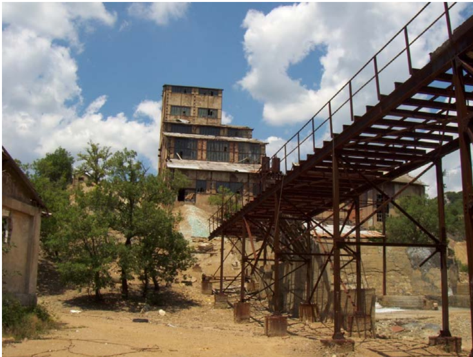
Σχήμα 10. Το εγκαταλελειμμένο εργοστάσιο εμπλουτισμού όπως είναι σήμερα.
