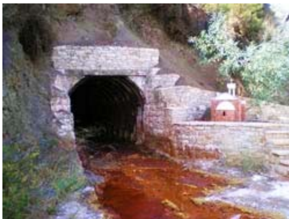
Σχήμα 26. Όξινη απορροή από τα μεταλλεία Καλαβασού, Κύπρος.
