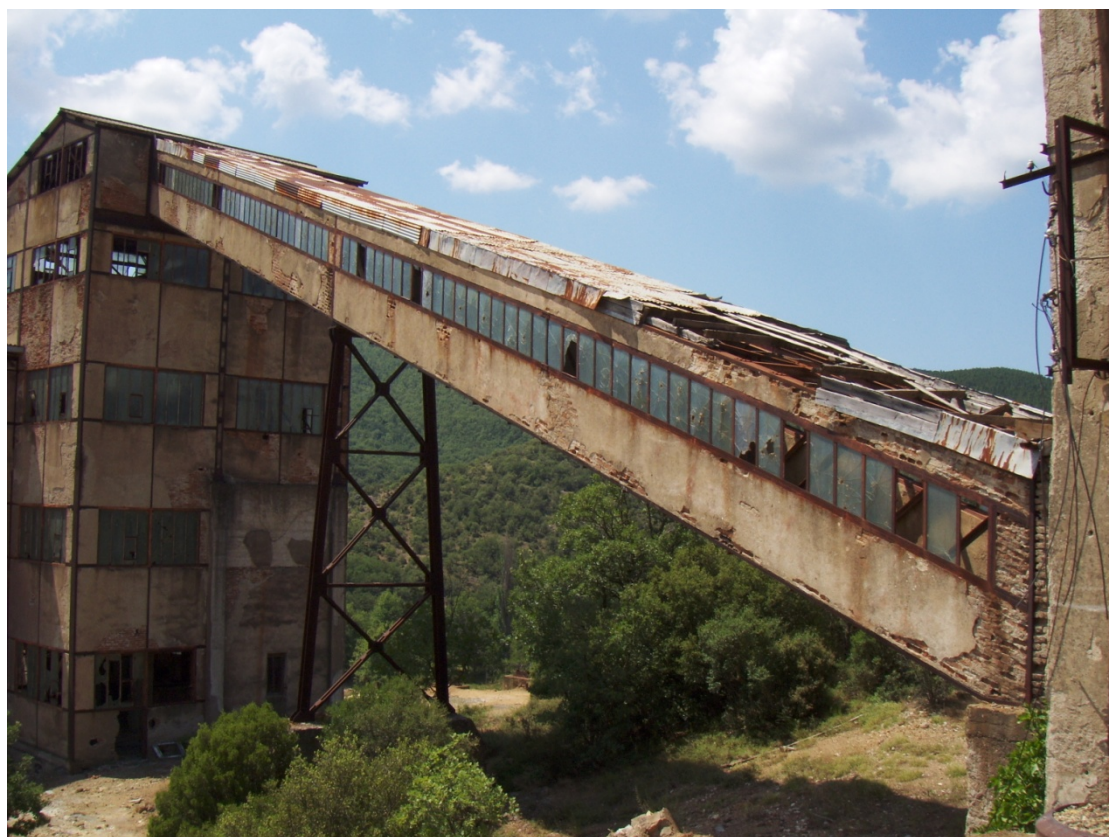
Σχήμα 7. Ο εναέριος κιβωτός διάδρομος που ένωνε τα δύο κτήρια για τη μεταφορά του μεταλλεύματος.
