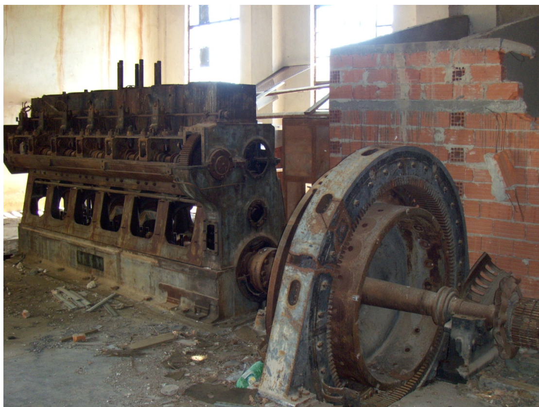
Σχήμα 8. Η ηλεκτρογεννήτρια των 650 HP όπως είναι σήμερα.
