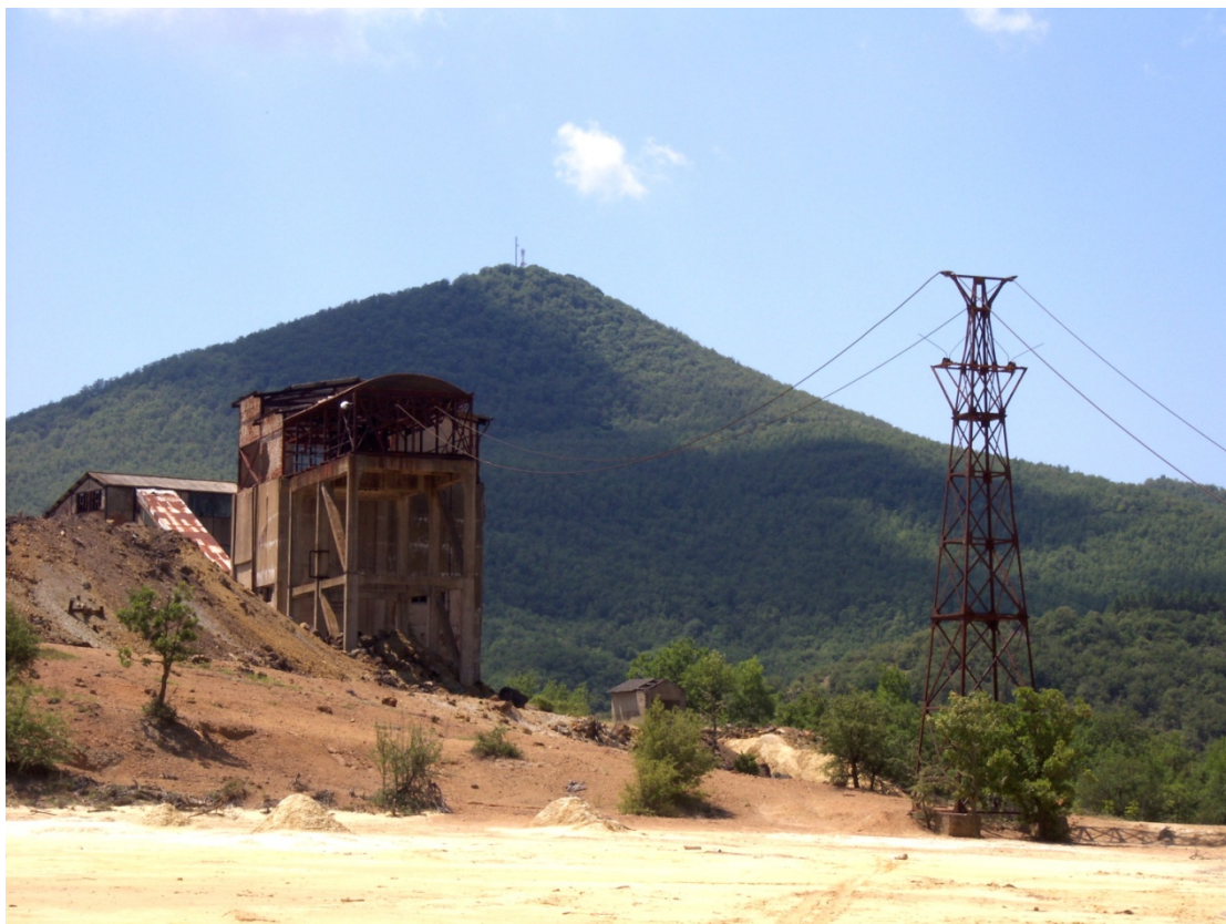
Σχήμα 16. Στο βάθος διακρίνουμε συσσώρευση στείων υλικών, δίπλα στη μονάδα θραύσης του μεταλλεύματος, που συμβάλουν στην εμφάνιση όξινης απορροής, λόγω της παρουσίας θειούχων ορυκτών. Βλέπουμε επίσης ένα μεταλλικό πυργίσκο, απομεινάρι του εναέριου συστήματος μεταφοράς μεταλλεύματος.
